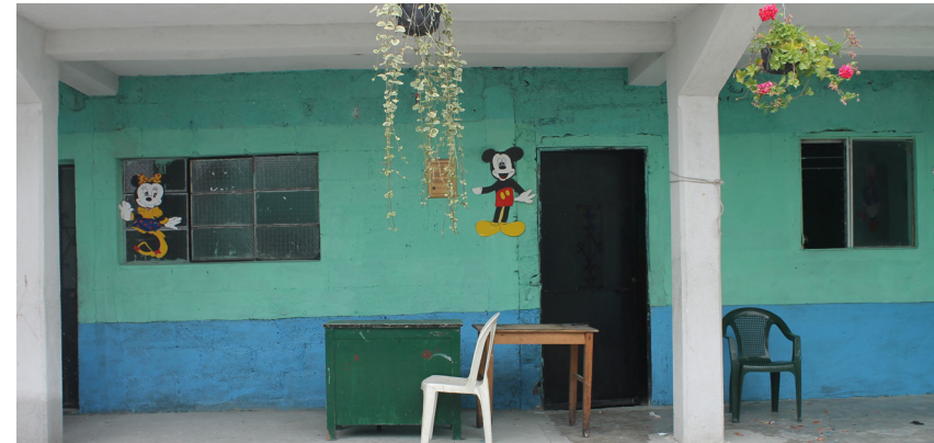
Primer nivel del edificio de la organización Casa Hogar Visión & Luz
