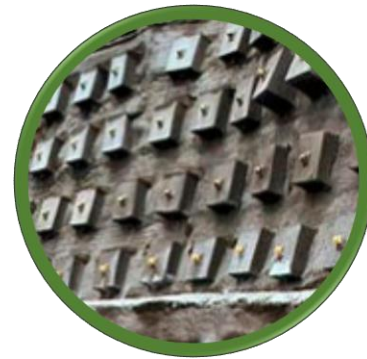
IMAGEN 52. MUROS DE CONTENCIÓN TIPO SOIL NAILING
