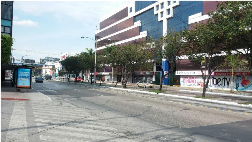
Imagen 59 Vista No. 7 Fuente: Elaboración Propia
