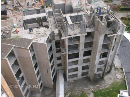
Ilustración #2 sistema de vigas y columnas http://beteitivacentro.blogspot.com/2014/11/sistemas-estructurales.html
