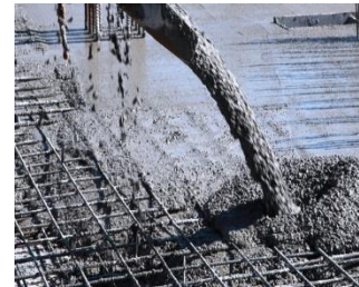
Ilustración de concreto siendo vertido
