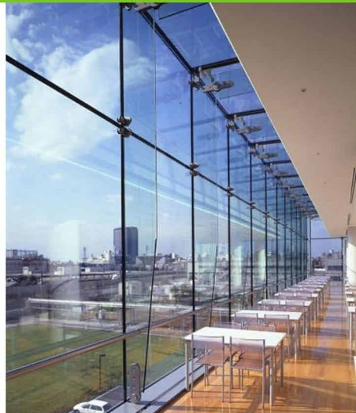
Vidrio templado, en ingresos e interiores. Permite tener visibilidad hacia el exterior.
