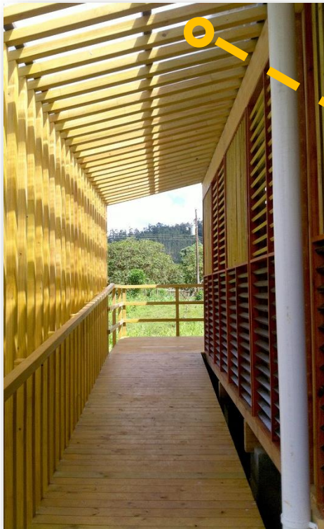
Pasillo de circulación
