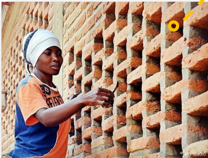
Construcción de muros del centro de apoyo
