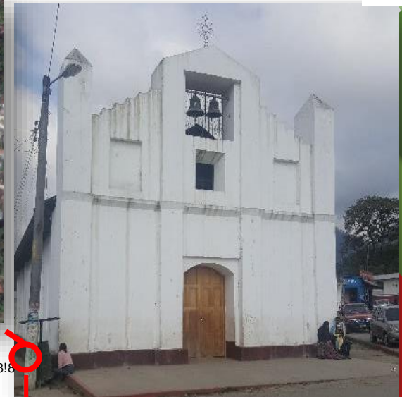
Edificio Religioso Purulhá Fuente: Propia
