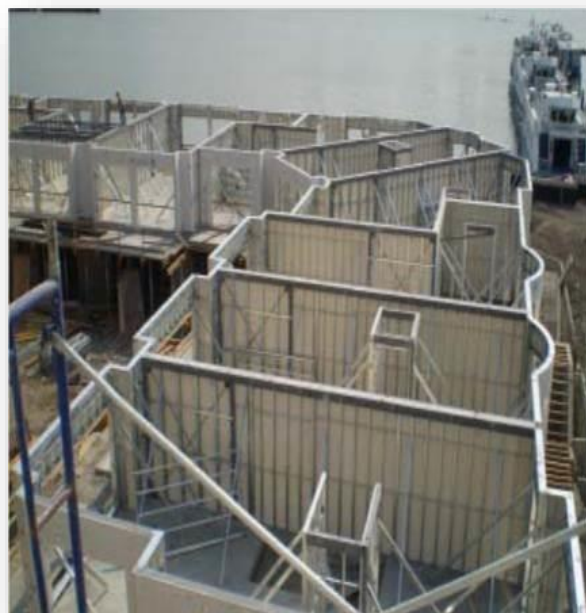
Sistema constructivo industrializado por formaleta
