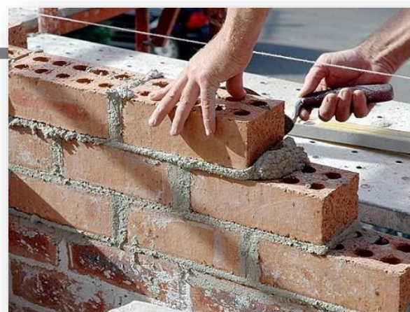
Sistema constructivo mampostería
