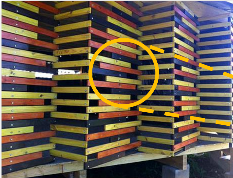
Madera utilizada como celosía colocada en fachadas laterales.
