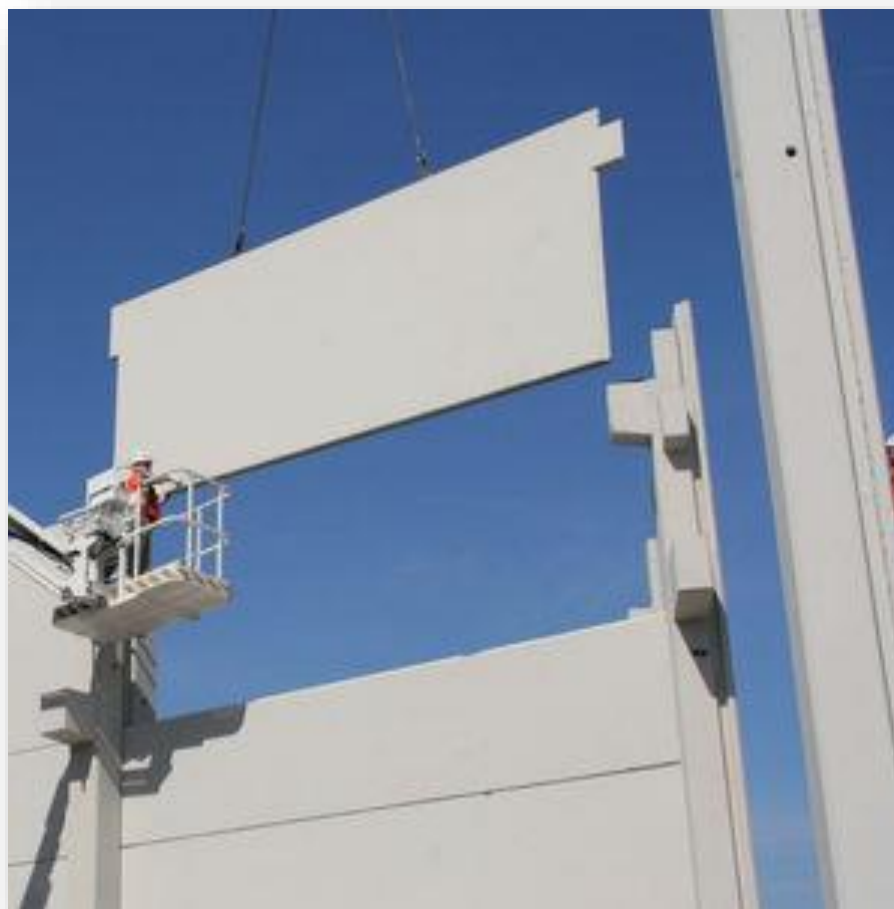
Peneles de concreto prefabricado.
