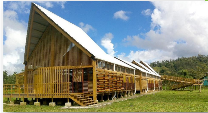
Fachada frontal centro de capacitación indígena kăpäcläjui Fuente: www.plataformaarquitectura.cl
