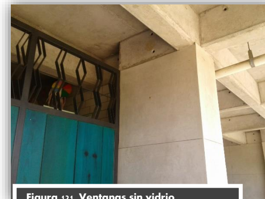
Figura 121. Ventanas sin vidrio Fuente: Fotografía tomada por el autor
