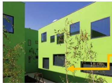
Figura 10. Vista exterior Fuente: Broto, 2015
