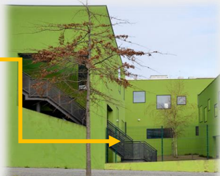
Figura 24. Vistas exterior escaleras Fuente: Barbosa&Benigno, 2010
