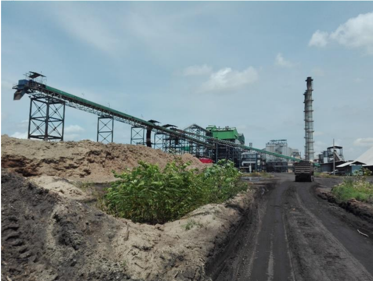
Imagen No. 16. Bandas transportadoras de bagazo hacia calderas Fotografía: Elaboración propia
