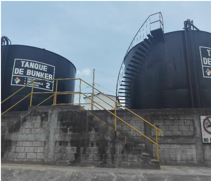
Imagen No. 33. Tanques de bunker Fotografía por: Eduardo Sanabria.
