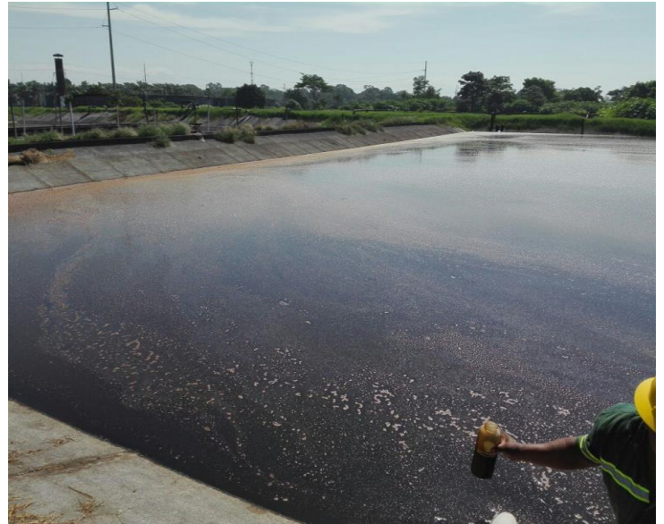
Imagen No. 34. Piletas de vinaza con estiércol para biogás Fotografía por: Eduardo Sanabria.
