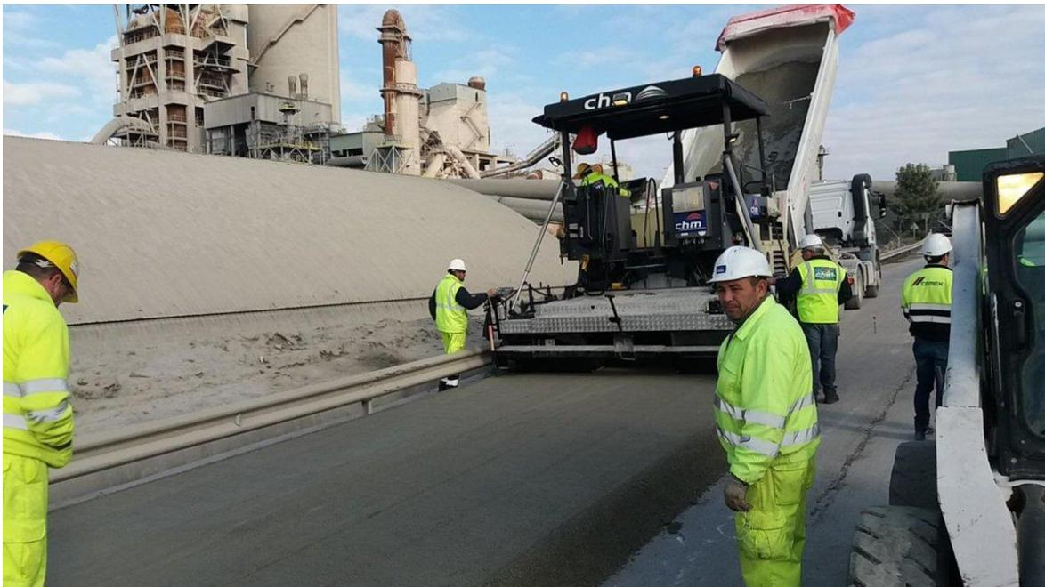
*Figura 13: proceso colocación CCR.
