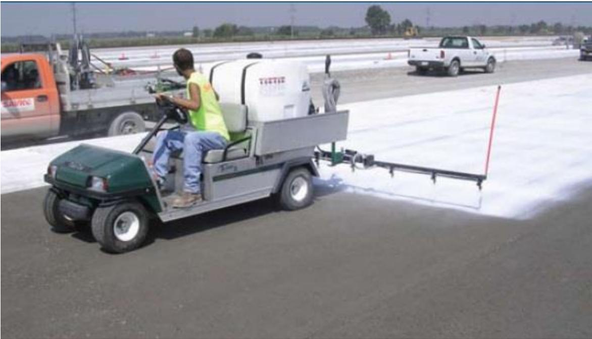
*Figura 23: aplicación compuesto químico para curado de CCR*
