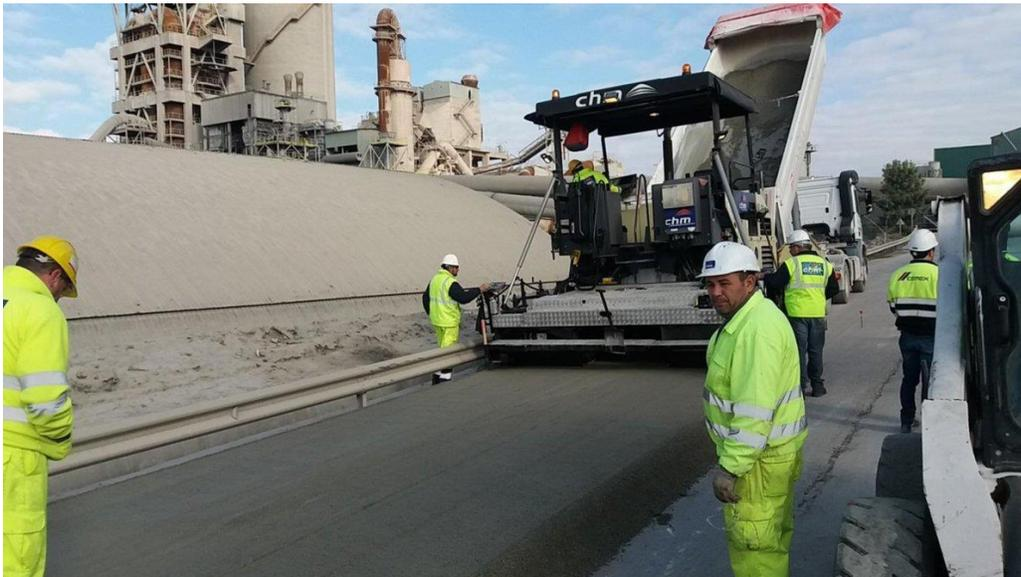
*Figura 2: concreto compactado con rodillo en pavimentos.
