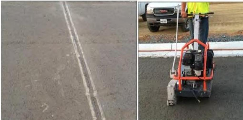
*Figura 21: corte de sizas y siza en CCR.
