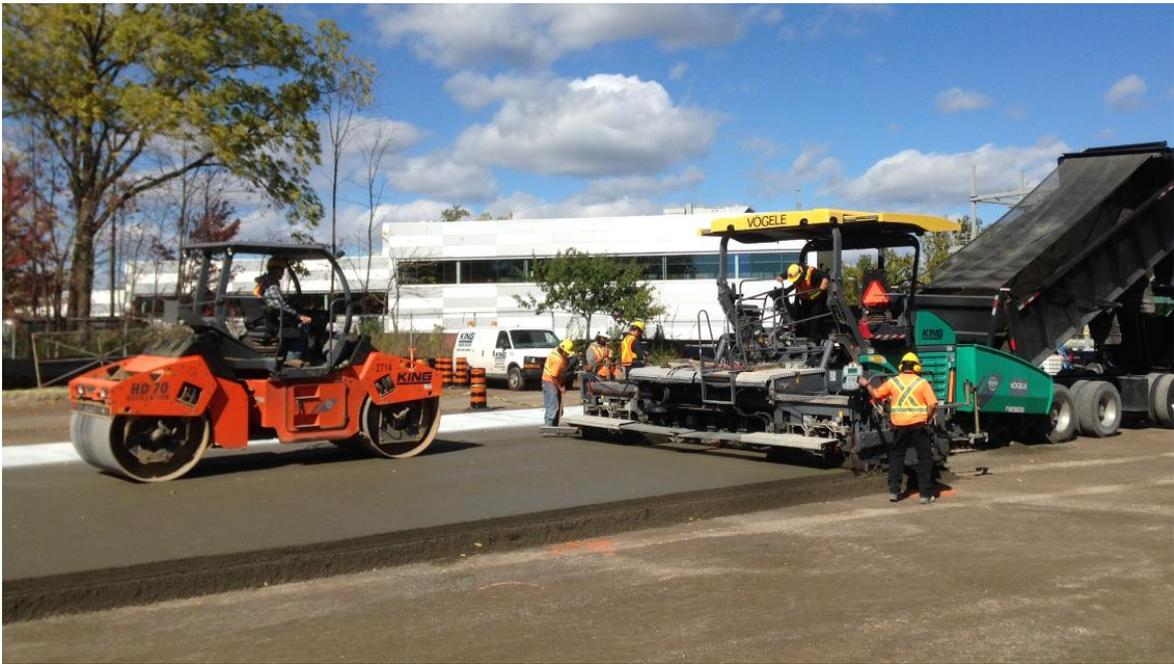
Figura 17: proceso constructivo pavimento CCR
