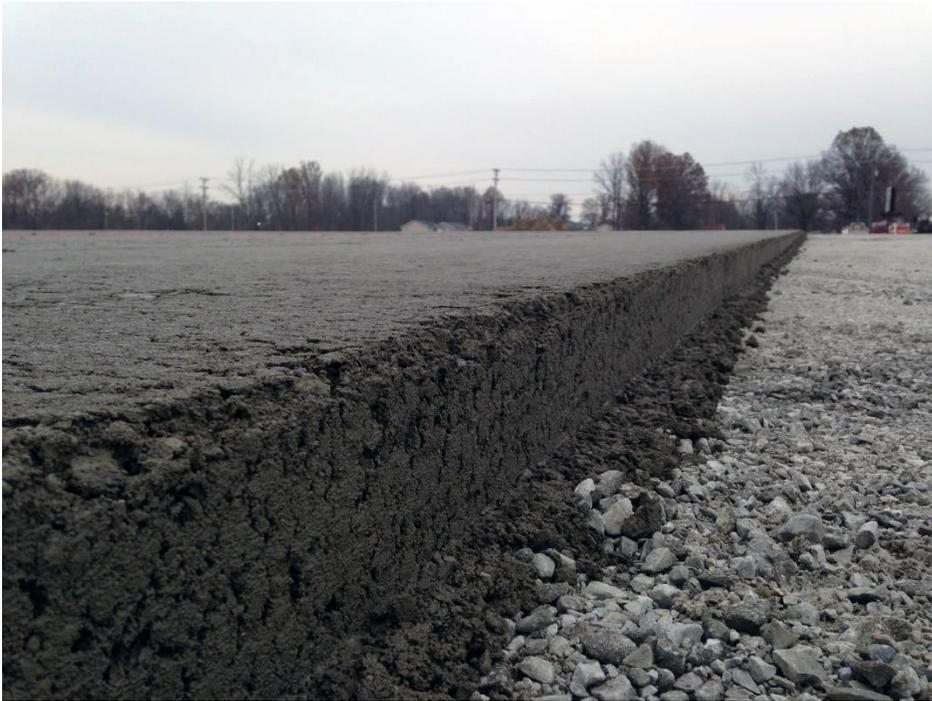
*Figura 53: acabado final bordillo pavimento CCR
