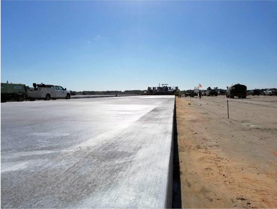
*Figura 50: curado con compuesto químico CCR
