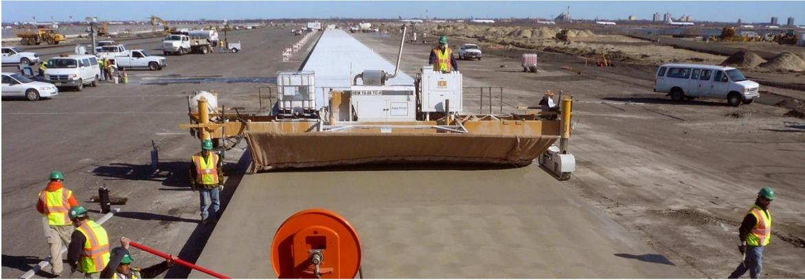
*Figura 22: aplicación curado con compuestos químicos*
