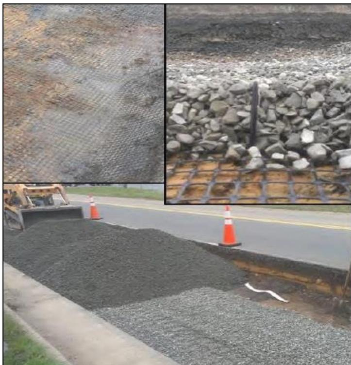
Figura 11: estabilización de base con agregado grueso.
