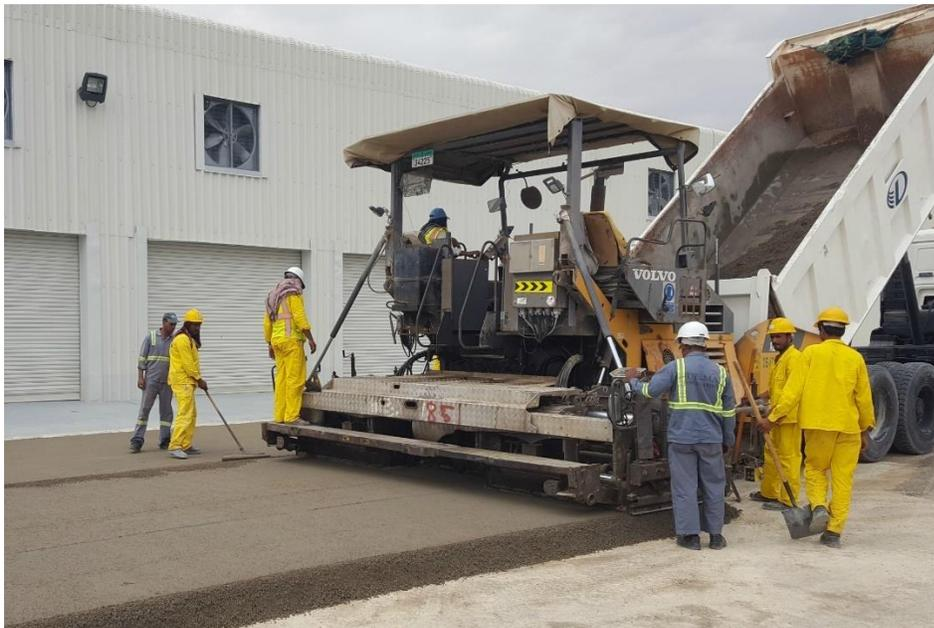
*Figura 10: preparación sub-rasante y sub-base.
