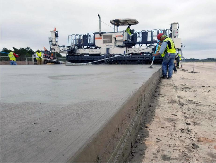
*Figura 48: acabado en pavimento CCR*
