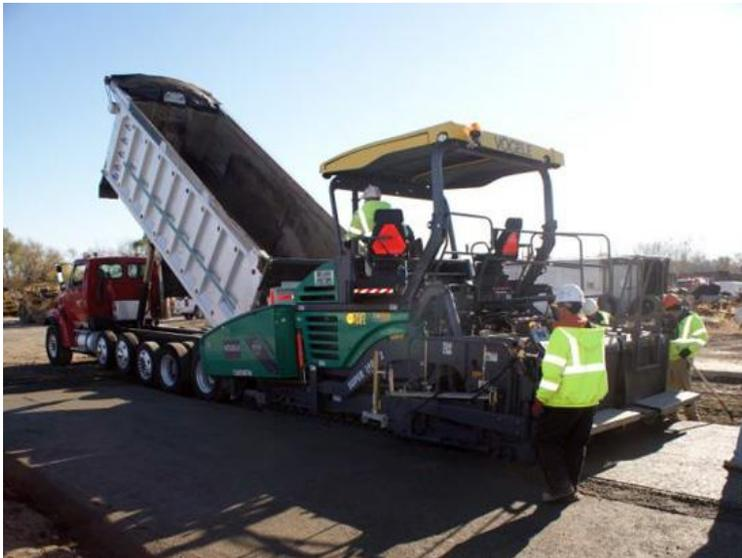
*Figura 1: concreto compactado con rodillo.
