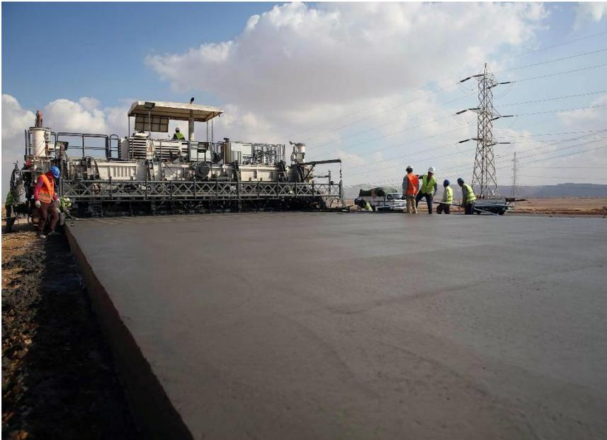
*Figura 55: estructura de pavimento final CCR'*
