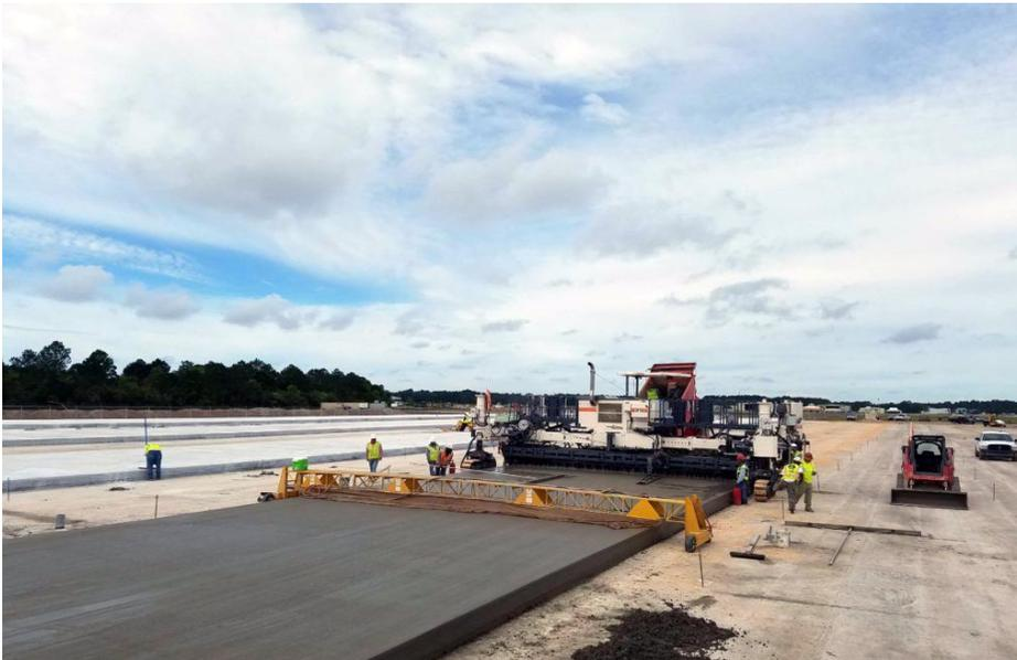
*Figura 49: sub-rasante y colocación pavimento CCR*
