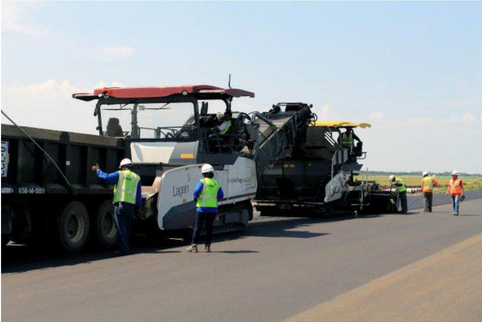
*Figura 56: proceso colocación pavimento CCR.
