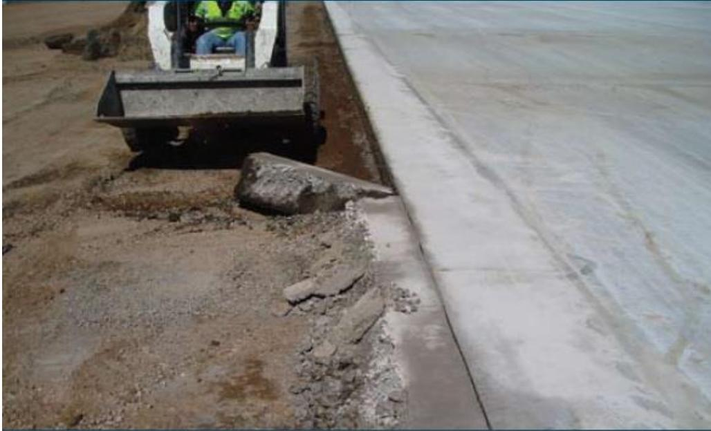
*Figura 20: junta final fría en pavimento de concreto compactado con rodillo.
