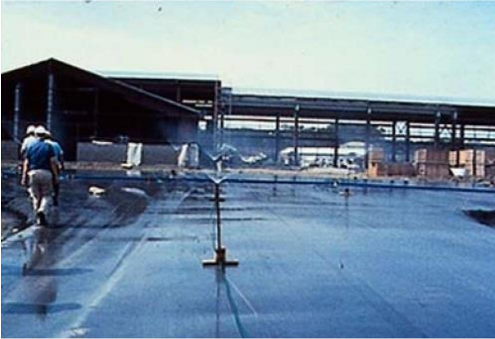
*Figura 24: aplicación de agua para curado de CCR.
