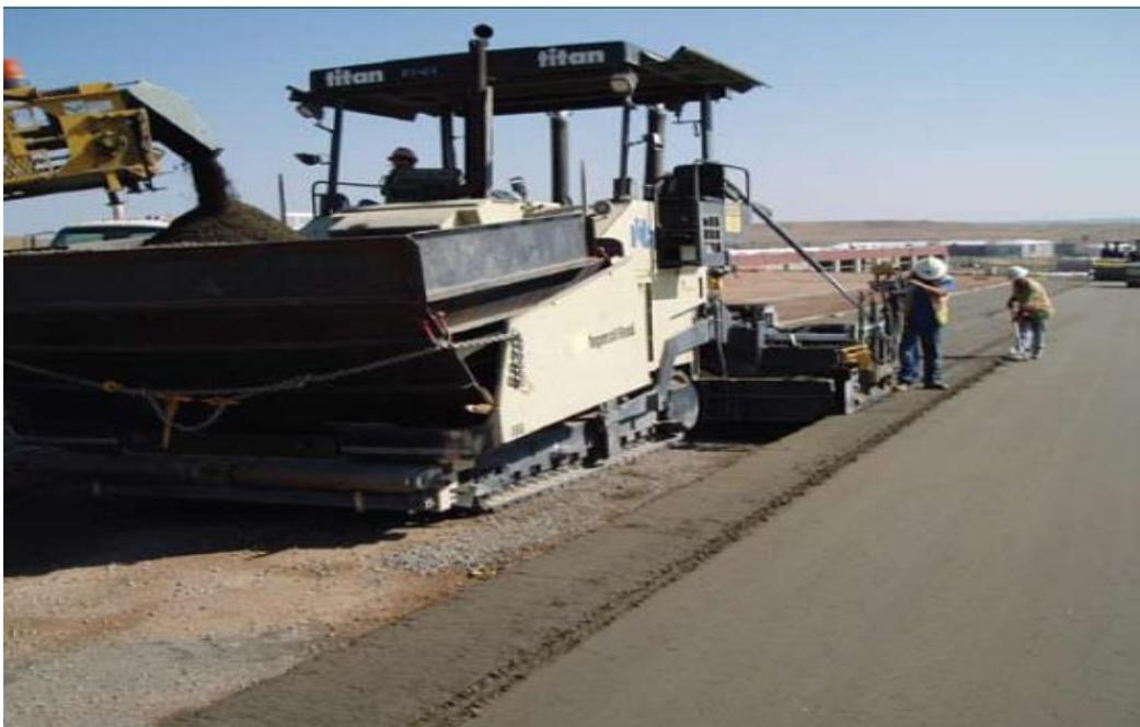
*Figura 19: junta fresca en pavimento de concreto compactado con rodillo.
