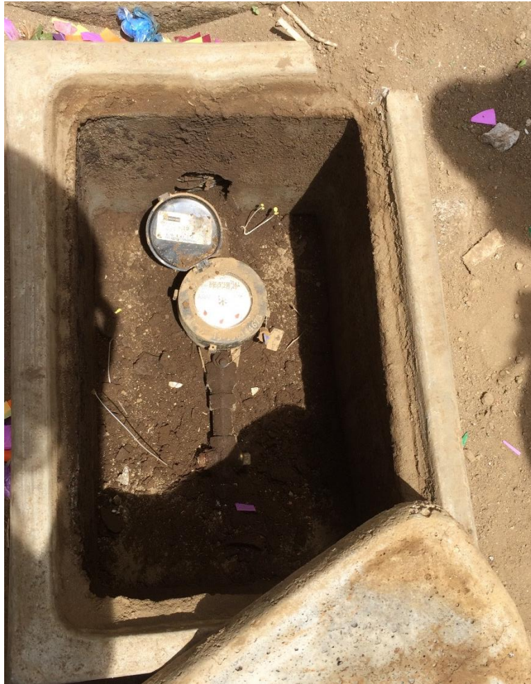
Figura 14. Llave y contador del sistema municipal de agua potable de la escuela Jardín de Amor (Fotografía: Jezyka Gonzalez)
