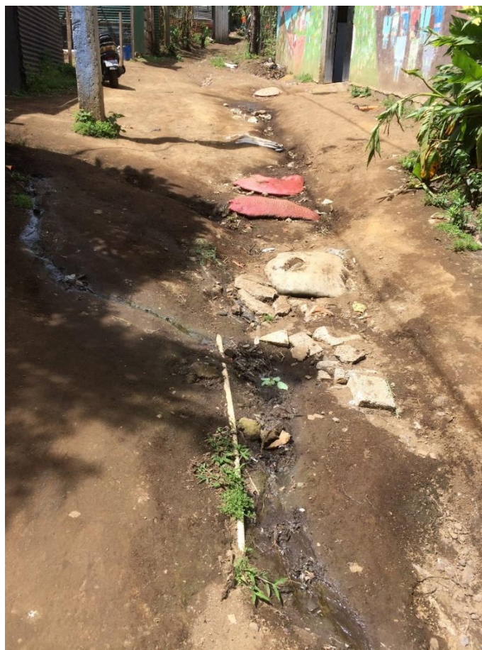
Figura 13. Entubaje de agua potable municipal que abastece a la escuela Jardín de Amor (Fotografía: Jezyka Gonzalez)
