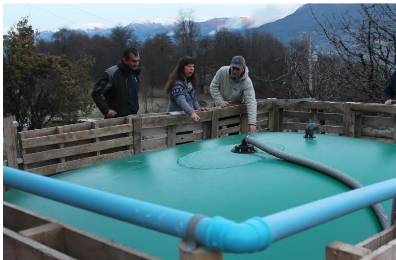
Figura 7. Cisterna flexible para almacenamiento de agua pluvial (INIA, 2016)
