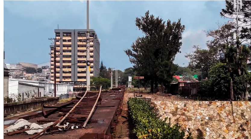
Puente de la penitenciaría sobre 7ma avenida zona 4 (fuente: ANADIE proyecto metro riel)
