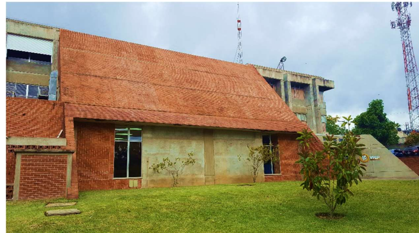
Ilustración 16: Fachada Oeste del Edificio "O". Fuente: INDIS, (2016).
