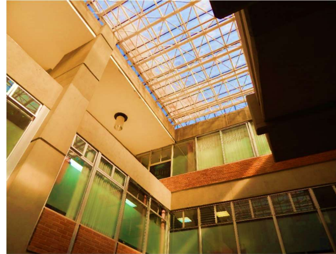
Ilustración 17: Interior del Edificio "O" con vista hacia el techo desde módulo de circulación central. Fuente: INDIS, (2016).
