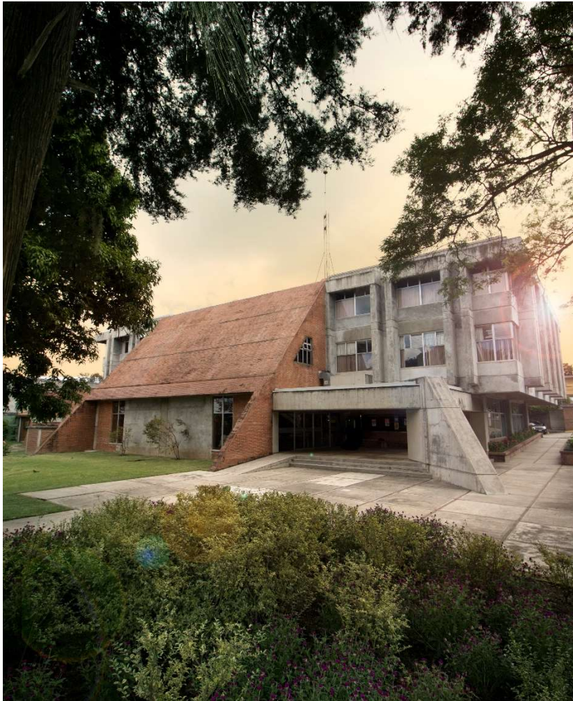
Ilustración 13: Fotografía del Edificio "O" Campus Central URL. Fuente: INDIS, (2017).
