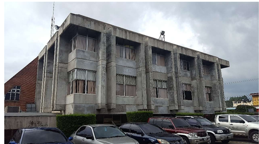
Ilustración 15: Vista Fachada Sur del Edificio "O", se observa el concreto y ladrillo expuestos, junto con los parteluces predominantes. Fuente: INDIS, (2016).
