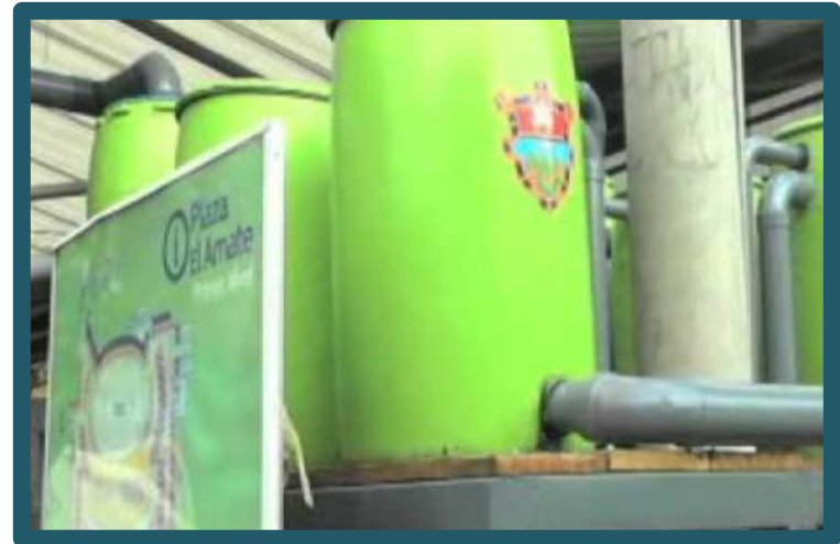
IMAGEN 9. Tanques de almacenamiento de agua lluvia en mercados municipales.
