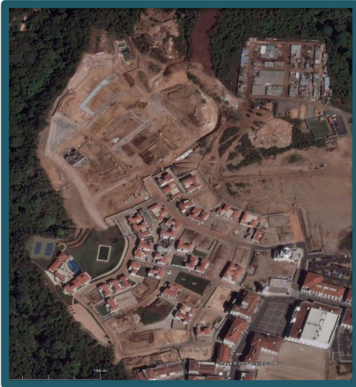
IMAGEN 1. Vista aérea de Ramblas 2015, Cayalá
