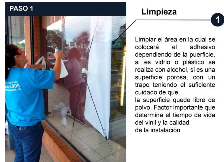
Imagen 15: Proceso de Instalación Paso 1
