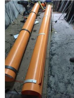
Imagen 53: Cambio abrazaderas de hierro por aluminio
