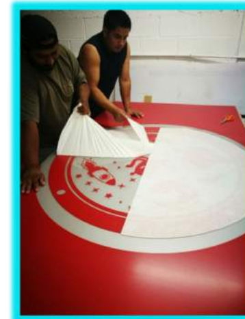
Imagen 21: Aplicación de vinil en superficie Fuente: Propia
