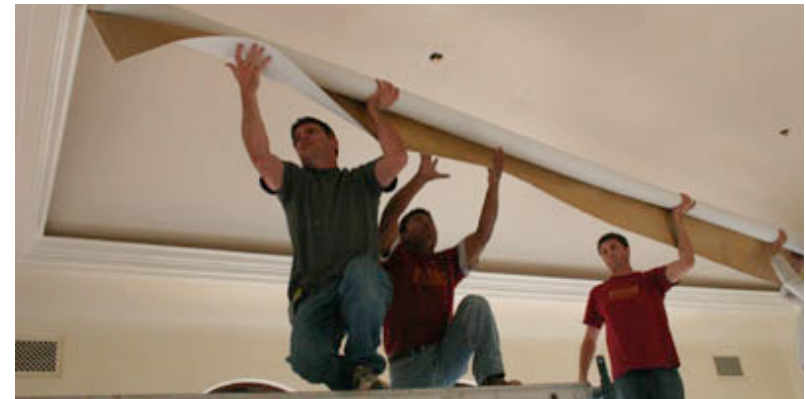
Instalación de canvas estirado en un techo. (2007)
