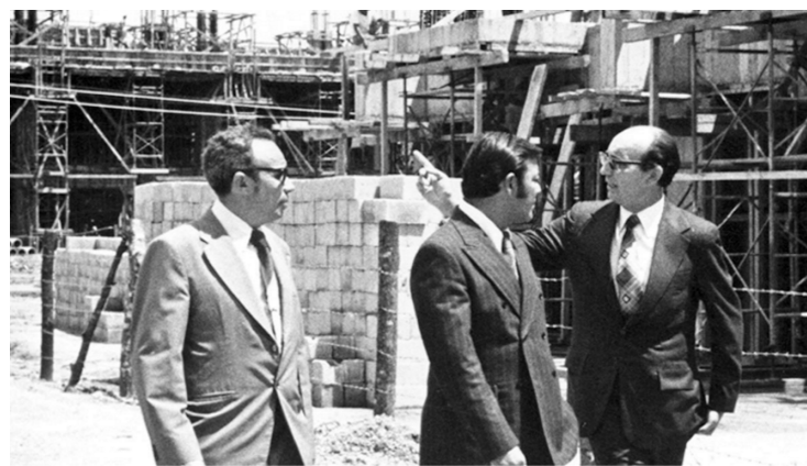
Construcción del Campus Central (2) Extraída del Portal de la Universidad Rafael Landívar
