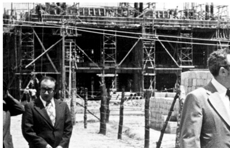
Construcción del Campus Central (1) Extraída del Portal de la Universidad Rafael Landívar
