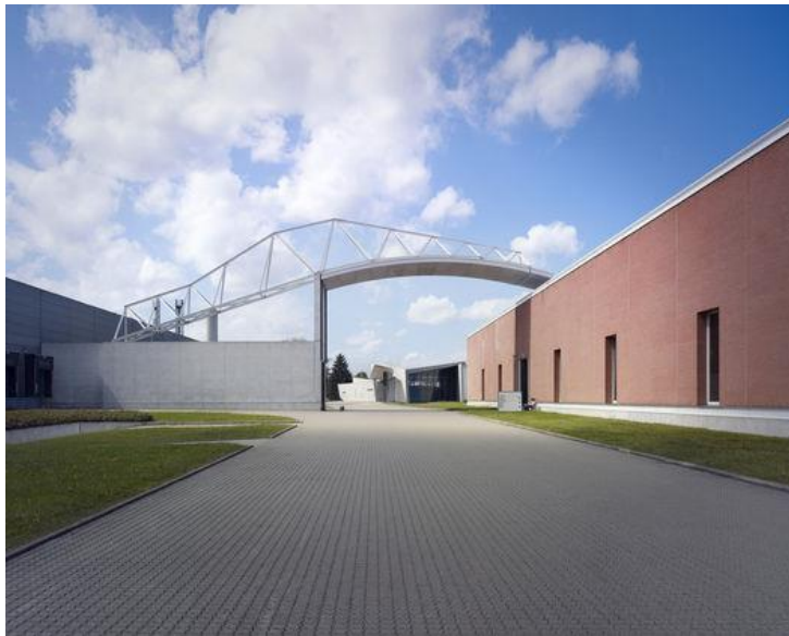
Imagen 26. Fuente: Fotografía de Iwan Baan (Nave de Producción).
