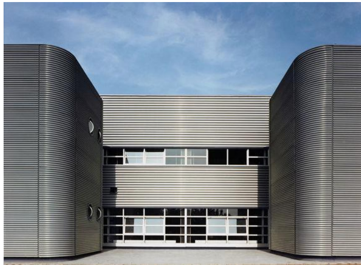
Imagen 32. Fuente: Fotografía de Iwan Baan (Nave de Producción).
