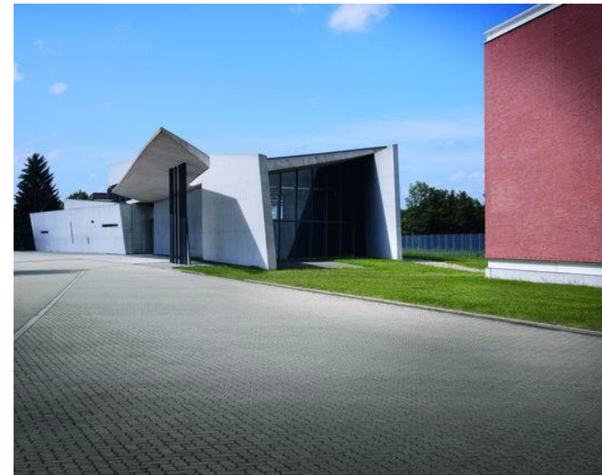
Imagen 27. Fuente: Fotografía de Iwan Baan (Estación de Bomberos).
