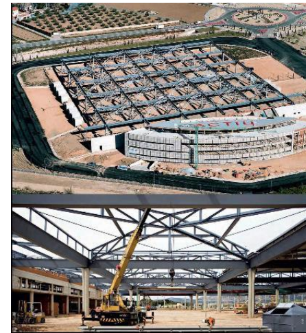
Imagen 51. Fuente: Fotografía de Enrique Carrazoni, Marcelo Martínez e Inma Juan (vista aérea e interna del edificio de Logística).
