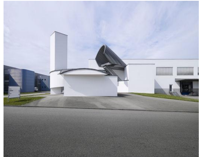
Imagen 31. Fuente: Fotografía de Iwan Baan (nave de producción).
