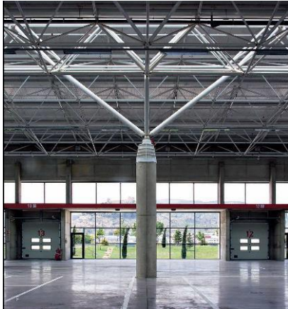
Imagen 45. Fuente: Fotografía de Enrique Carrazoni, Marcelo Martínez e Inma Juan (Vista interior y estructura de Naves de producción).
