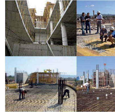
Imagen 62. Fuente: Fotografía de Enrique Carrazoni, Marcelo Martínez e Inma Juan (construcción Edificio Corporativo).
