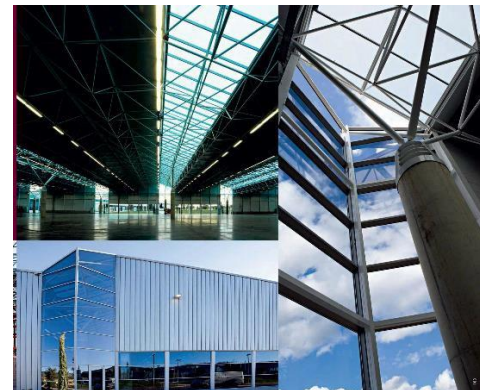
Imagen 44. Fuente: Fotografía: Enrique Carrazoni, Marcelo Martínez e Inma Juan (Estructura de Naves de producción).
