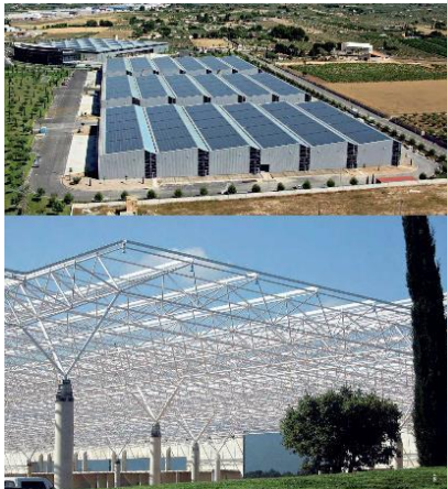
Imagen 46. Fuente: Fotografía de Enrique Carrazoni, Marcelo Martínez e Inma Juan (Proceso de construcción de Naves de producción).
