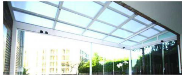
DETALLE DE ESTRUCTURA METÁLICA CON CUBIERTA DE VIDRIO. UTILIZADO EN LOS TRAGALUCES DEL EDIFICIO DE TALLERES Y ÁREA DE EMPLEADOS (VER PLANTA DE TECHOS). FUENTE: http://www.legaspi.com.mx/
