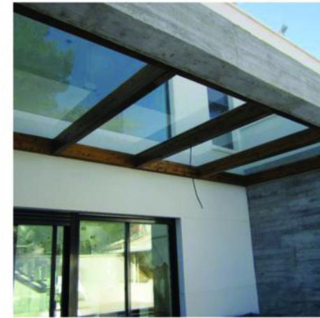
VIGAS METÁLICAS IMITACIÓN DE MADERA. UTILIZADAS EN LA CUBIERTA EXTERIOR DEL SALÓN DE USOS MÚLTIPLES. FUENTE: https://www.habitissimo.es/presupuestos/muro-hormigon
