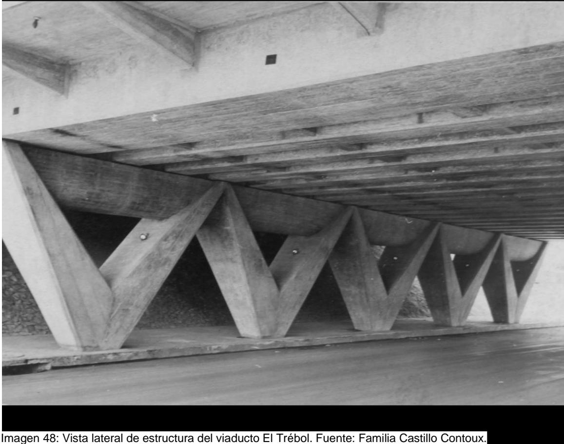
Imagen 48: Vista lateral de estructura del viaducto El Trébol. Fuente: Familia Castillo Contoux.
