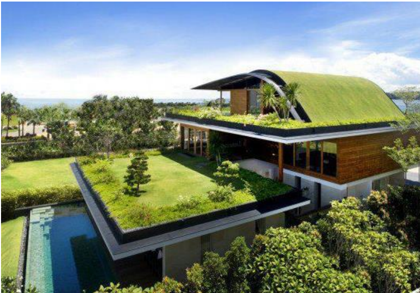
CUBIERTA VERDE EN UN PROYECTO RESIDENCIAL
