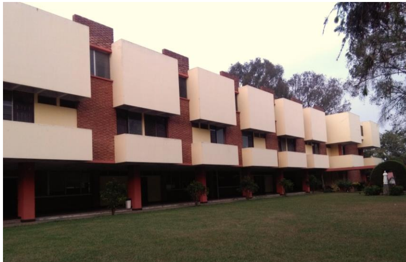
EDIFICIO DE DORMITORIOS PARA PRENOVICIOS FUENTE: Elaboración propia (2016)
