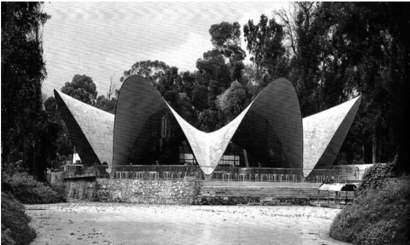
RESTAURANTE LOS MANANTIALES POR CANDELA EN XOCHIMILCO, MEXICO FUENTE: http://www.jotdown.es/wp-content/uploads/2011/11/Los-manantiales.jpg
