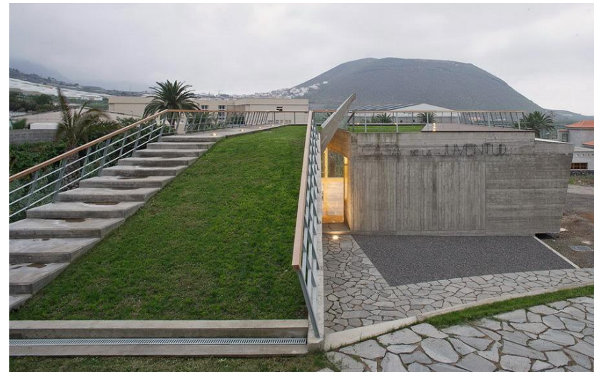
INGRESO A LA TERRAZA Y AL EDIFICIO
