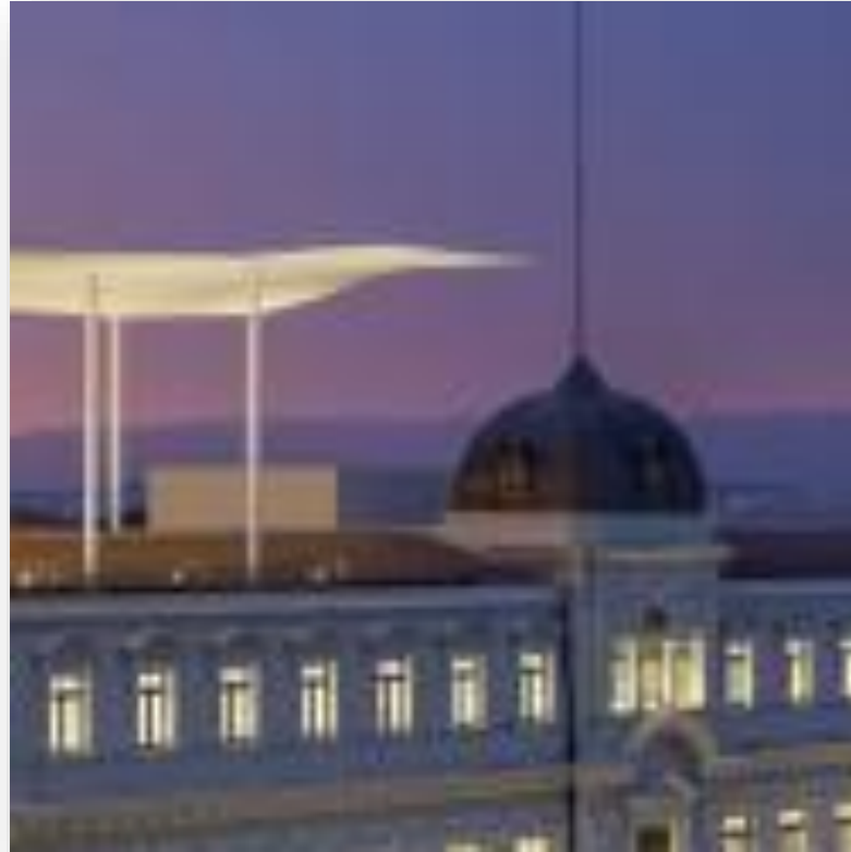
Vista exterior del edificio.
