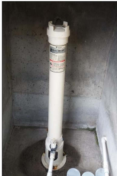
Figura 4. Clorador de la PTAR de la Universidad Rafael Landívar.
