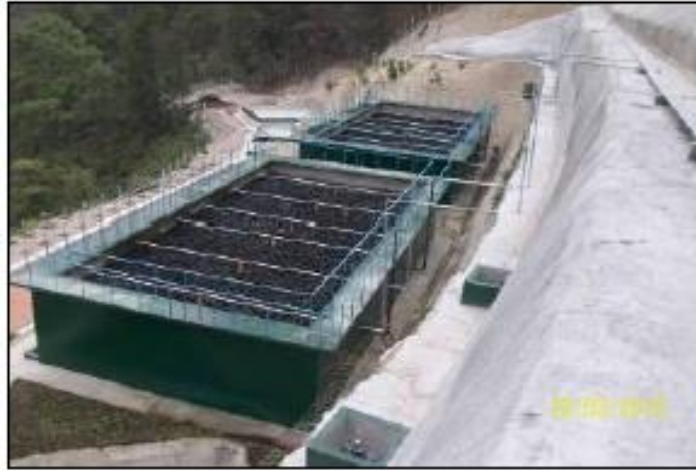
Figura 3. Filtros percoladores de la PTAR de la Universidad Rafael Landívar.
