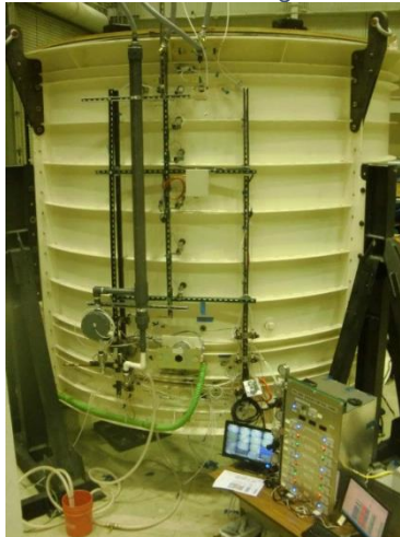
Ilustración 39: Sistema de control electrónico para la inspección de la tubería de agua fría.
