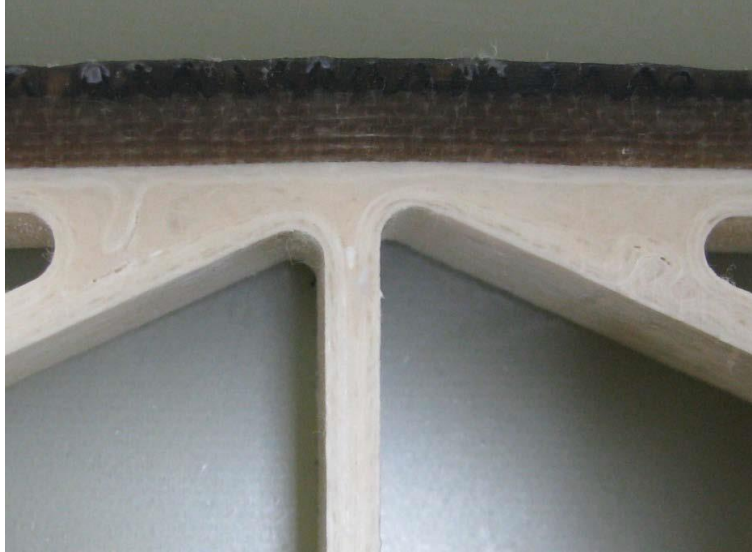
Ilustración 38: Núcleo de una tubería de agua fría.
