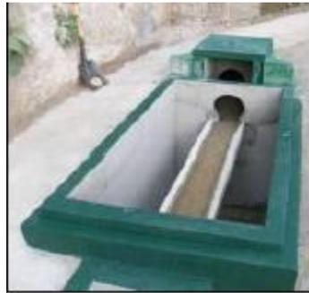
Figura 3. Canal de Demasías de la PTAR de la URL, CC. Marzo 2010.
