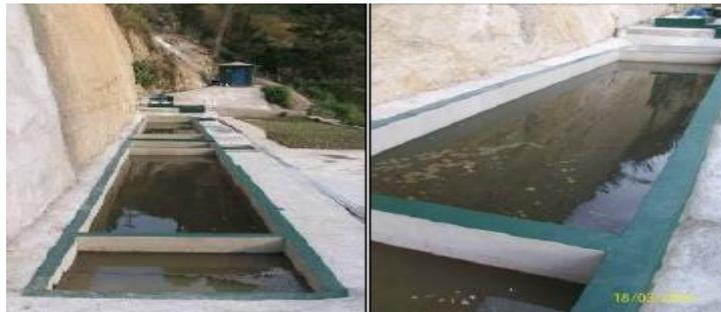
Figura 6. Sedimentador Primario de la PTAR de la URL, CC. Marzo 2010.
