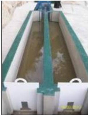
Figura 4. Canal de Rejas y Desarenador de la PTAR de la URL, CC. Marzo 2010.
