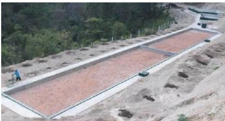
Figura 11. Patio de Secado de Lodos de la PTAR de la URL, CC. Marzo 2010.
