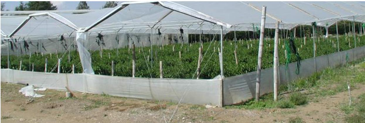
Figura 15. Ejemplo de invernaderos con techos de material de polietileno. (AGE, 2009)
