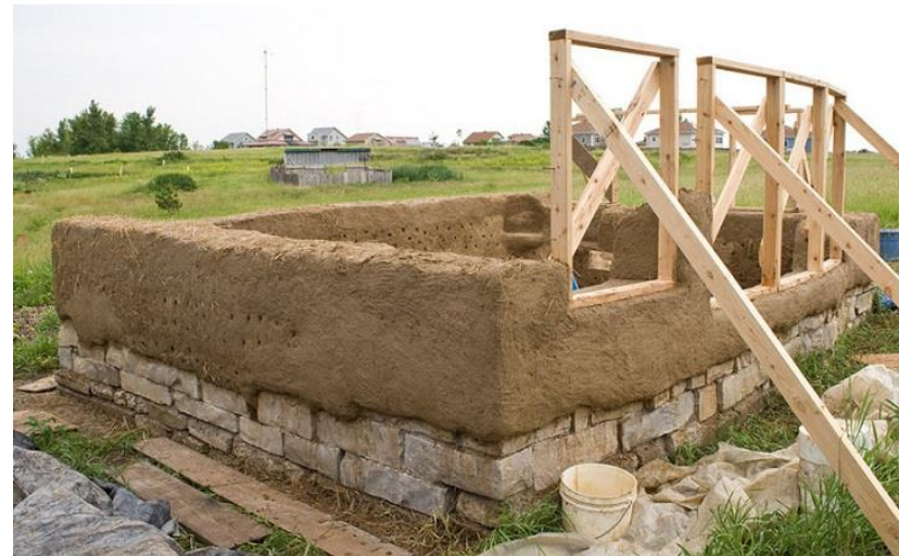
Construcción con cob. Fuente: http://www.inspirationgreen.com/cob-under-construction
