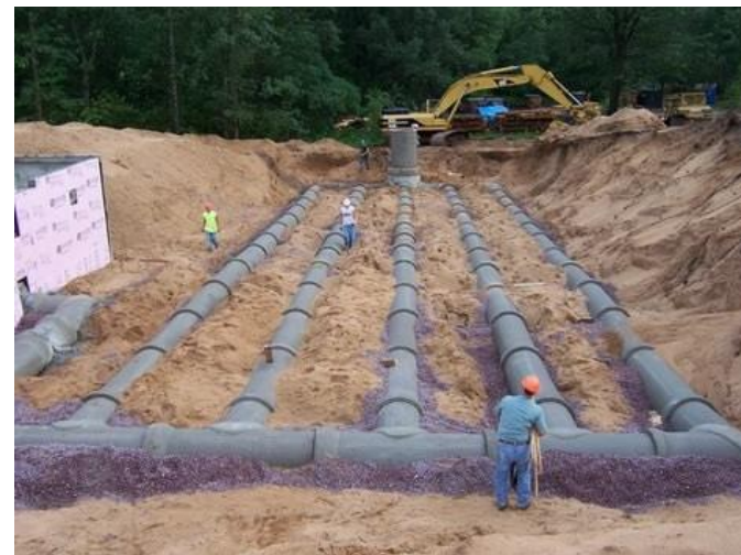
Instalación de un pozo canadiense. Fuente: http://www.solarweb.net/forosolar/attachments/aeroterminia/8434d1382393740-aeroterminia-pozo-canadiense-image.jpg
