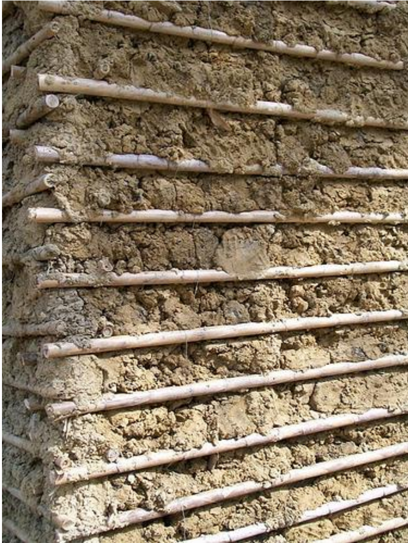
Construcción con bajareque. Fuente: http://tectonicablog.com/wp-content/uploads/2011/09/4595991560_dc29b6e88c.jpg
