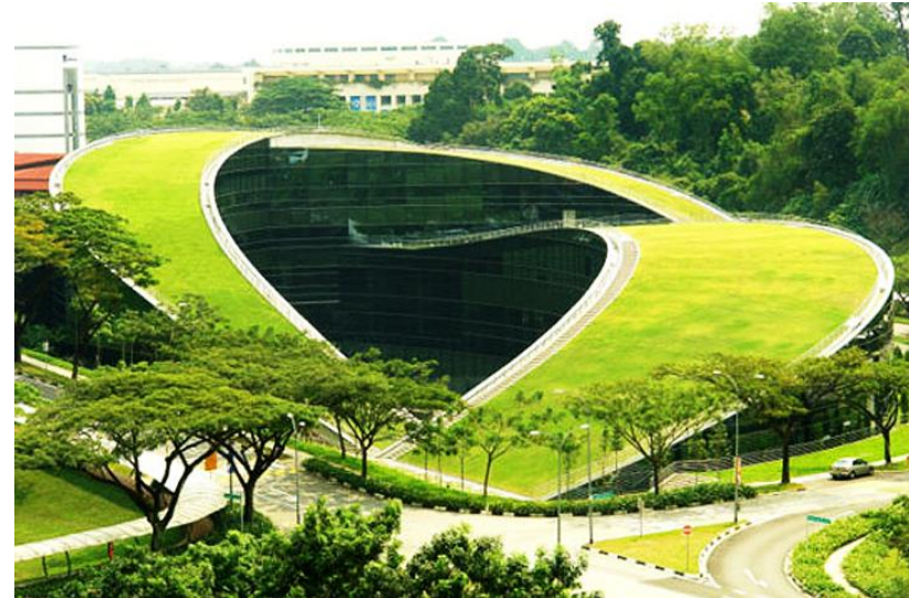
Cubierta ajardinada. Nanyang Technological University, Singapur.
