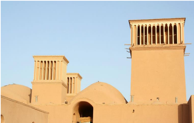
Torres de viento de múltiples bocas.
