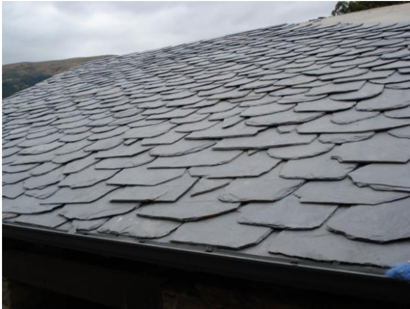
Construcción con piedra pizarra en cubierta de techo.
