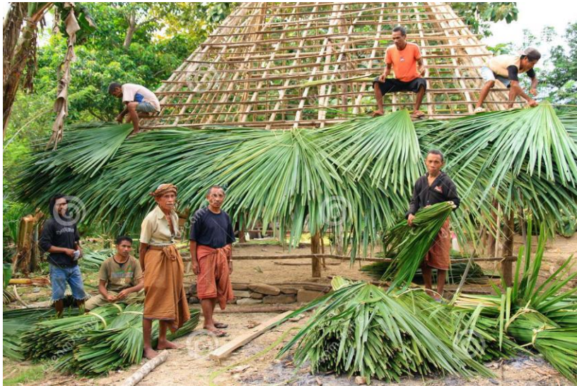
Construcción de cubierta con hojas de palma. Fuente: http://thumbs.dreamstime.com/z/construcci%C3%B3n-de-una-choza-tradicional-en-timor-del-oeste-16855384.jpg
