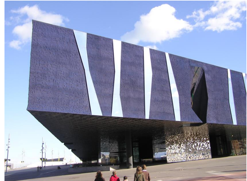
Protección del acceso exterior. Edificio Forum. Barcelona, España. Fuente: Elaboración propia
