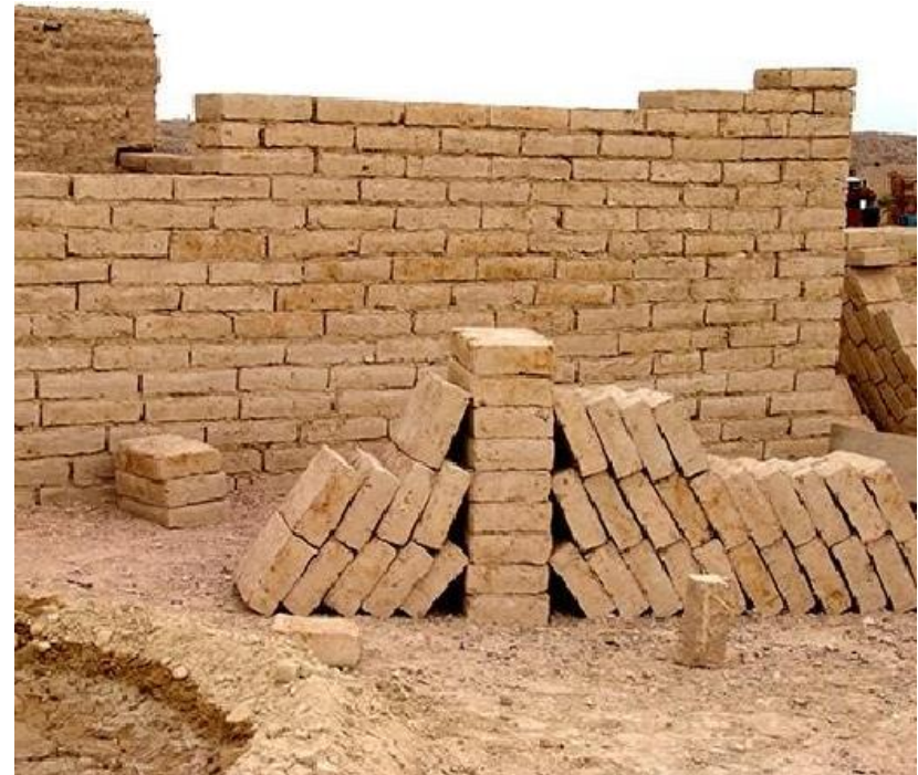
Construcción con adobe.
