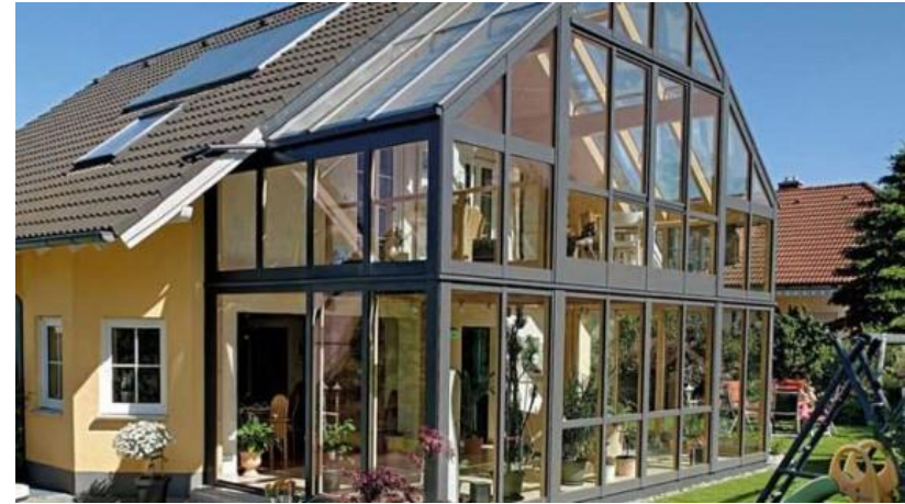
Invernadero adosado a vivienda.
