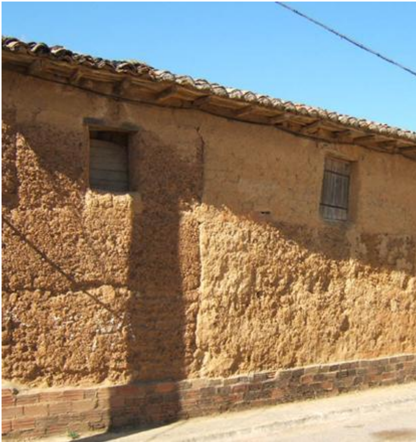
Construcción con tapial.
