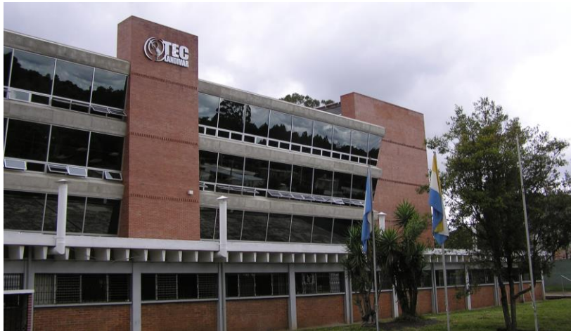
Construcción con ladrillo tubular. TEC Universidad Rafael Landívar. Fuente: Elaboración propia
