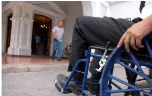
Figura 20. Instalaciones no adecuadas para la movilización de personas en silla de ruedas. Fuente: www.losandes.com.ar Recuperado: 14 de noviembre de 2015
