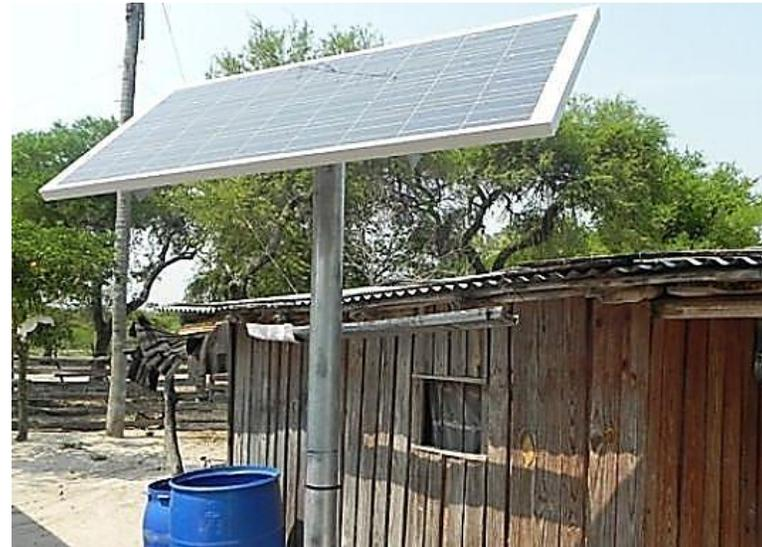
**Figura 17. Sistema Solar Fotovoltaico para vivienda rural**
