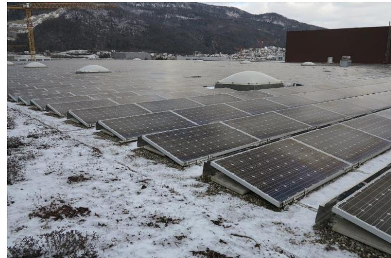
**Figura 29.** Paneles fotovoltaicos en tejado de edificio de Migros Neuendorf
