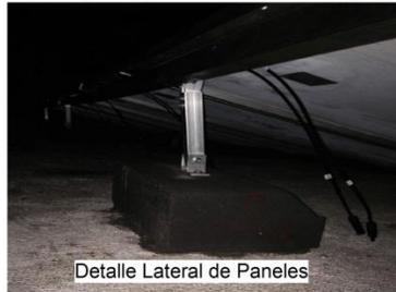
Instalación de 4 unidades de Paneles Fotovoltaicos orientados hacia el sur a un ángulo de 15 grados
