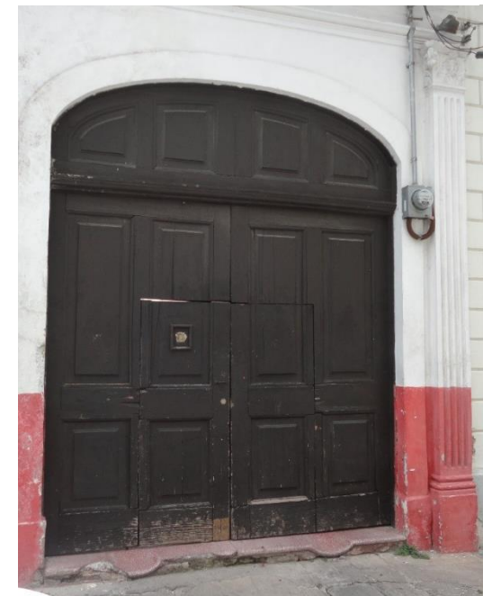
Ilustración 13. Portón de acceso. Fuente: foto propia.
