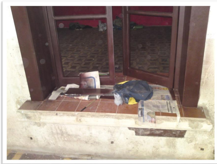
Ilustración 65. Aplicación de laca en ventanas. Foto: A.L. López
