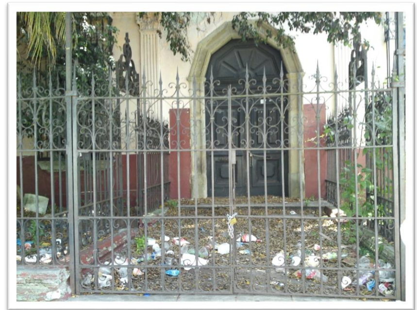
Ilustración 60. Puerta principal de acceso. Foto: A.L. López
