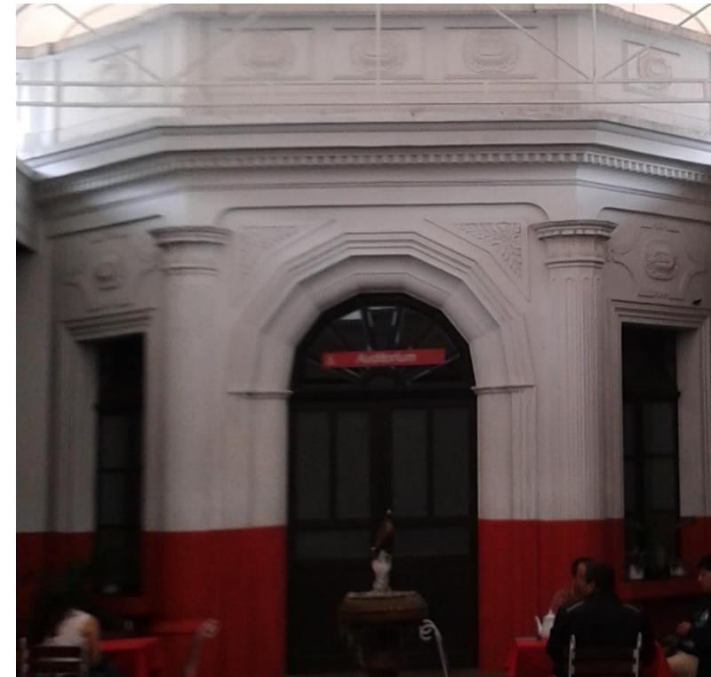
Ilustración 17. Foto de fachada de Comedor. Fuente: foto propia.
