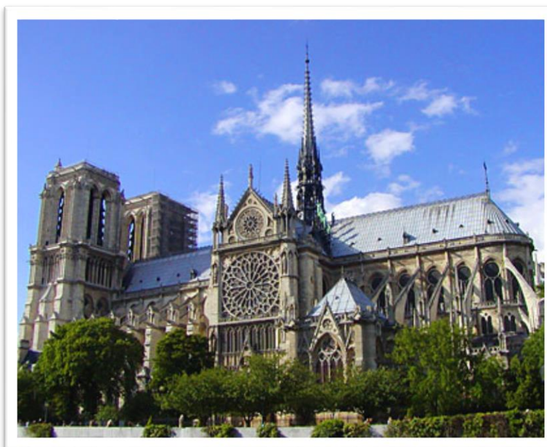
Ilustración 13. Restauración de Catedral de Notre Dame-París 1857. Fuente: http://viollet-le-duc-usat.blogspot.com/2011/05/obras-restauracion-de-la-ciudad.html
