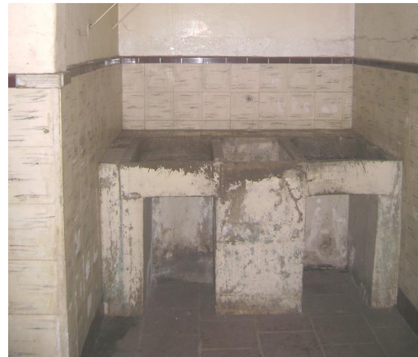
Ilustración 10. Pila. Fuente: foto propia.
