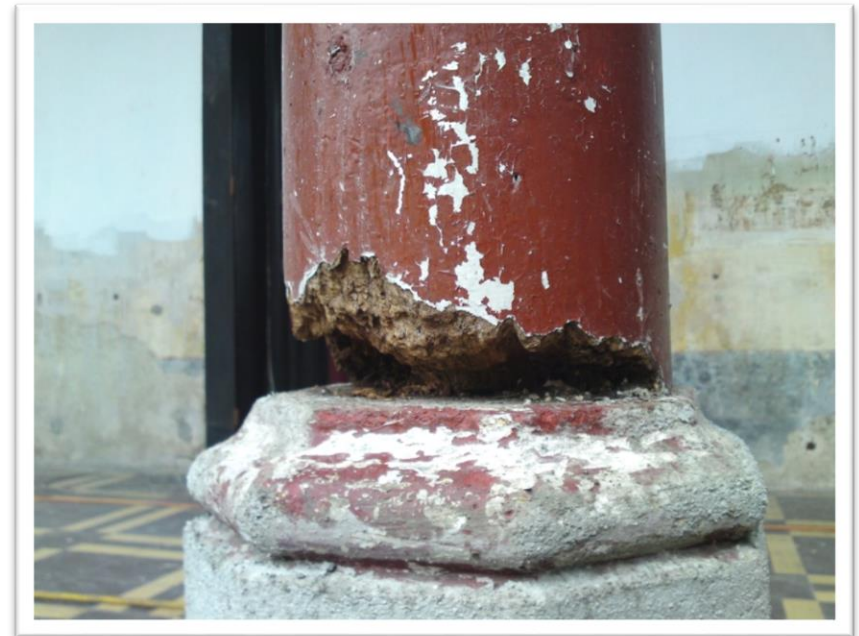
Ilustración 66. Daño en columna de patio. Foto: A. L. López
