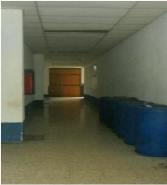
En el hospital nacional el pasillo que conduce al área de mantenimiento e inventario es utilizado para colocar toneles.
