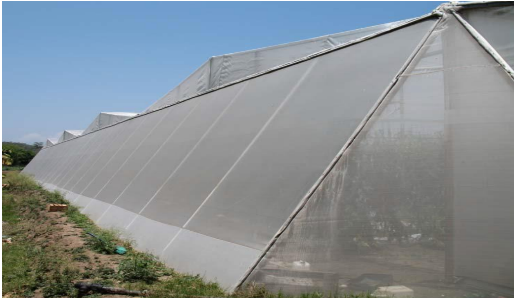
FIGURA 2. Vista lateral de la casa malla.
