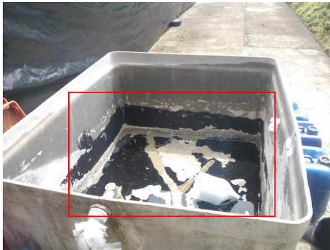
**Imagen 23.** El agua se queda estancada en el vaciado del depósito.
