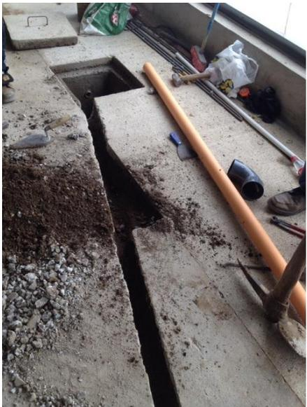
3. Se introduce la tubería en el encaminado, se levanta con un codo a 20 cms del suelo y se prosigue con la fundición del cemento. Debe realizarse la fundición completa del suelo, esperar un tiempo prudente de fraguado y colocar la primera hilera de block.
