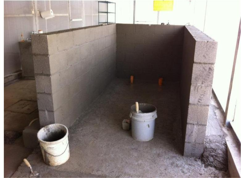
5. Luego de haber levantado las paredes, se construirá la grada lateral que tiene 20 cms de alto x 20 cms de ancho. y que sube con la rampa de entrada al sistema.
