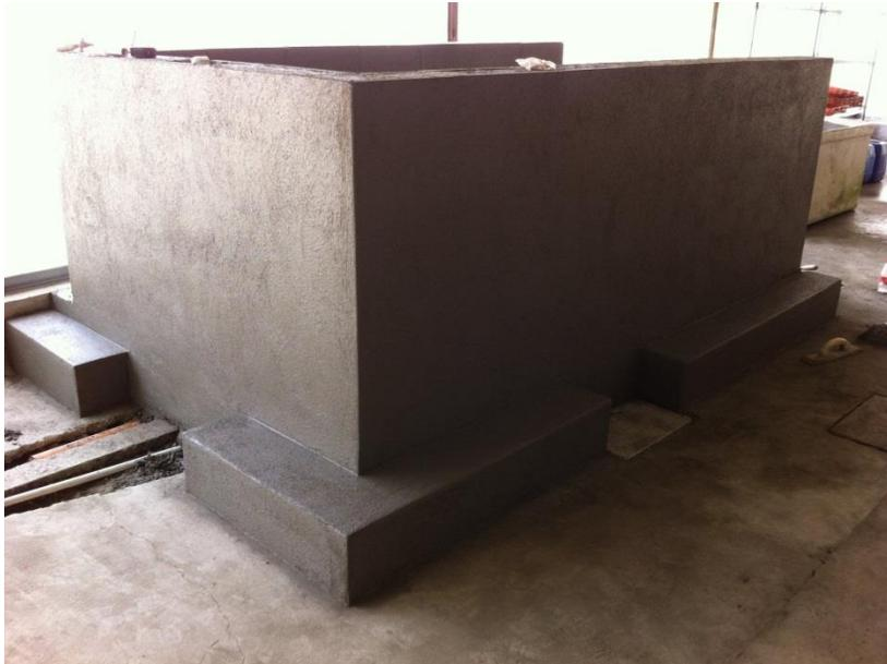
6. Cuando la grada sea terminada, se realiza un alisado de cemento en la parte externa y un cepillado para darle textura, esta cara no importa que no vaya alisada completamente, ya que no tendrá contacto con el agua.
