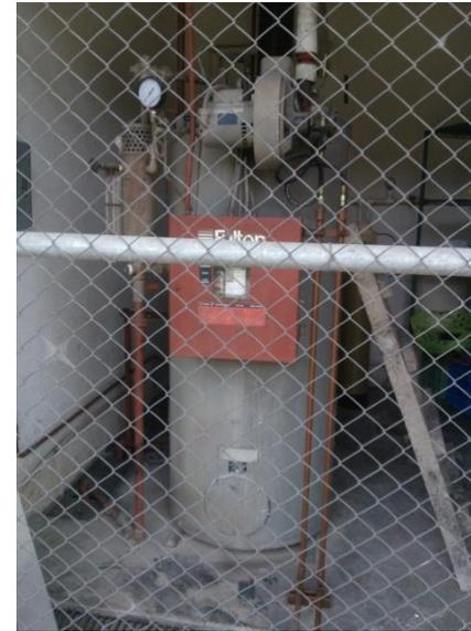
**Imagen 28.** Caldera de alimentación para autoclave.
