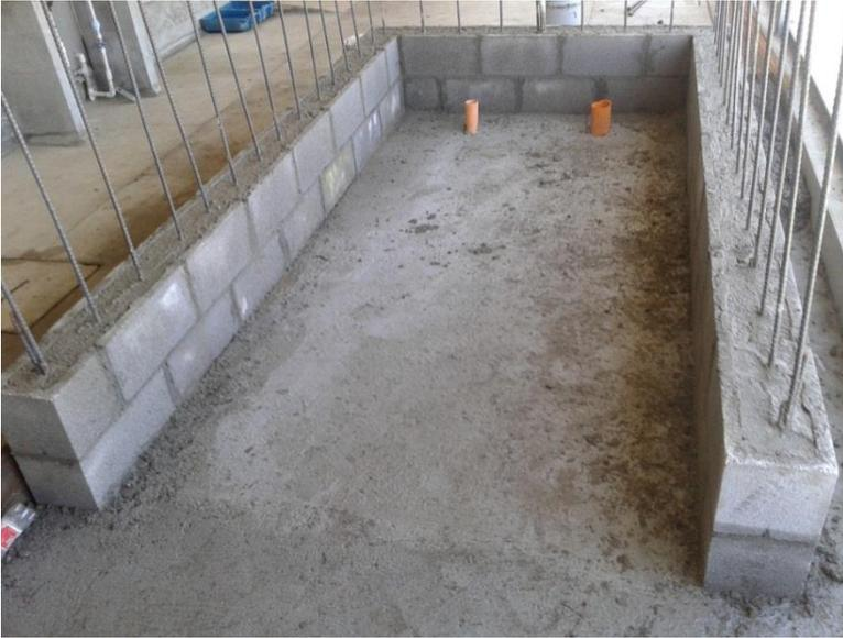
Cuando se termine de levantar la segunda fila se debe colocar una varilla de hierro a todo el largo de la pared, esto para darle más resistencia a las paredes y a la fundición que se realizará internamente en los blocks.
