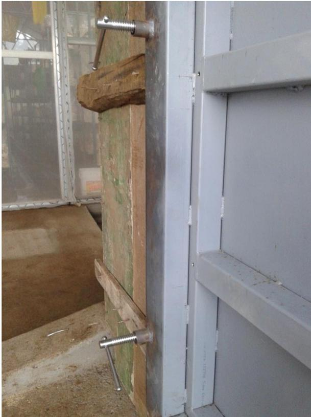
12. Ya que se realizó la fundición se espera por 3 días para quitar la formaleta y tallar el concreto, cepillado por afuera y alisado con medias cañas por adentro.
