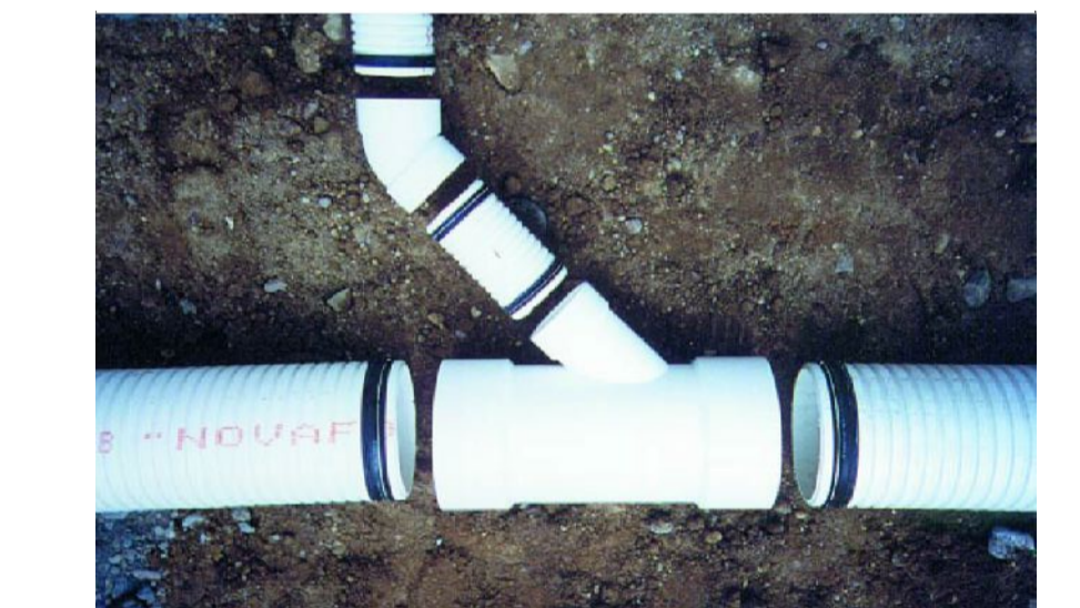
DETALLE DE DERIVACION DE DOMICILIAR
