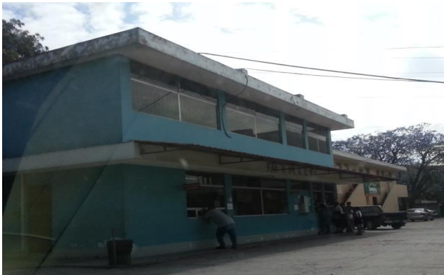
Imagen 59. "Cubierta de lámina y acero". Fuente propia. Abril 2013.
