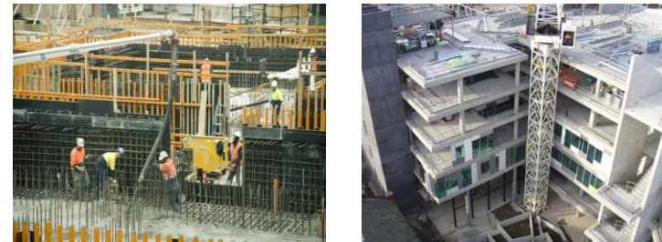
Imagen 39 – 40: “Estructura y construcción”. Fuente: http://www.oliviaappeal.com/ Marzo 2013
