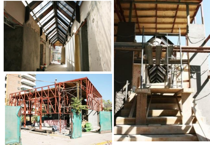
Imágenes 66 - 68. "Estructura y construcción de la Clínica". Fuente: www.plataformaarquitectura.cl Abril 2013.
