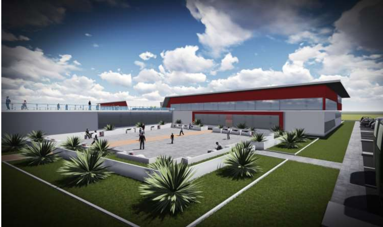
VISTA ESTE DEL EDIFICIO
