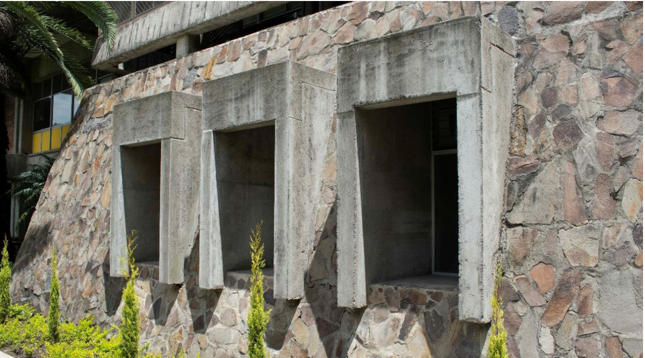
Figura 69. Fachada exterior de los servicios sanitarios en el primer nivel del Edificio J (fotografía por Pedro Antonio Ayau, © 2020 Vrip).
