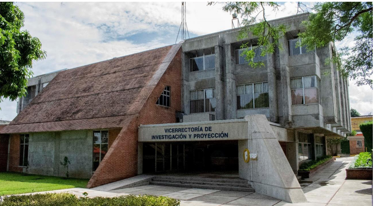
Figura 70. Vista frontal al Edificio O, Universidad Rafael Landívar (fotografía por Pedro Antonio Ayau, © 2020 Vrip).
