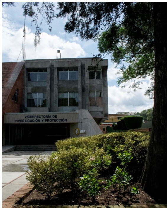
Figura 28, Edificio O, Campus Central de la Universidad Rafael Landívar (fotografía por Pedro Ayau, © 2020 Vrip).
