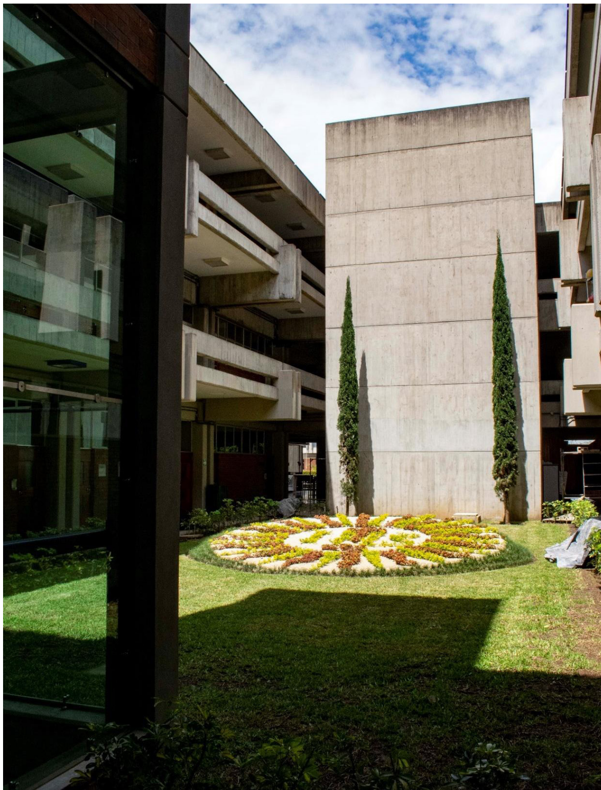
Figura 40. Interior Edificio L, Campus Central Universidad Rafael Landívar (fotografía por Pedro Antonio Ayau, © 2020 Vrip).
