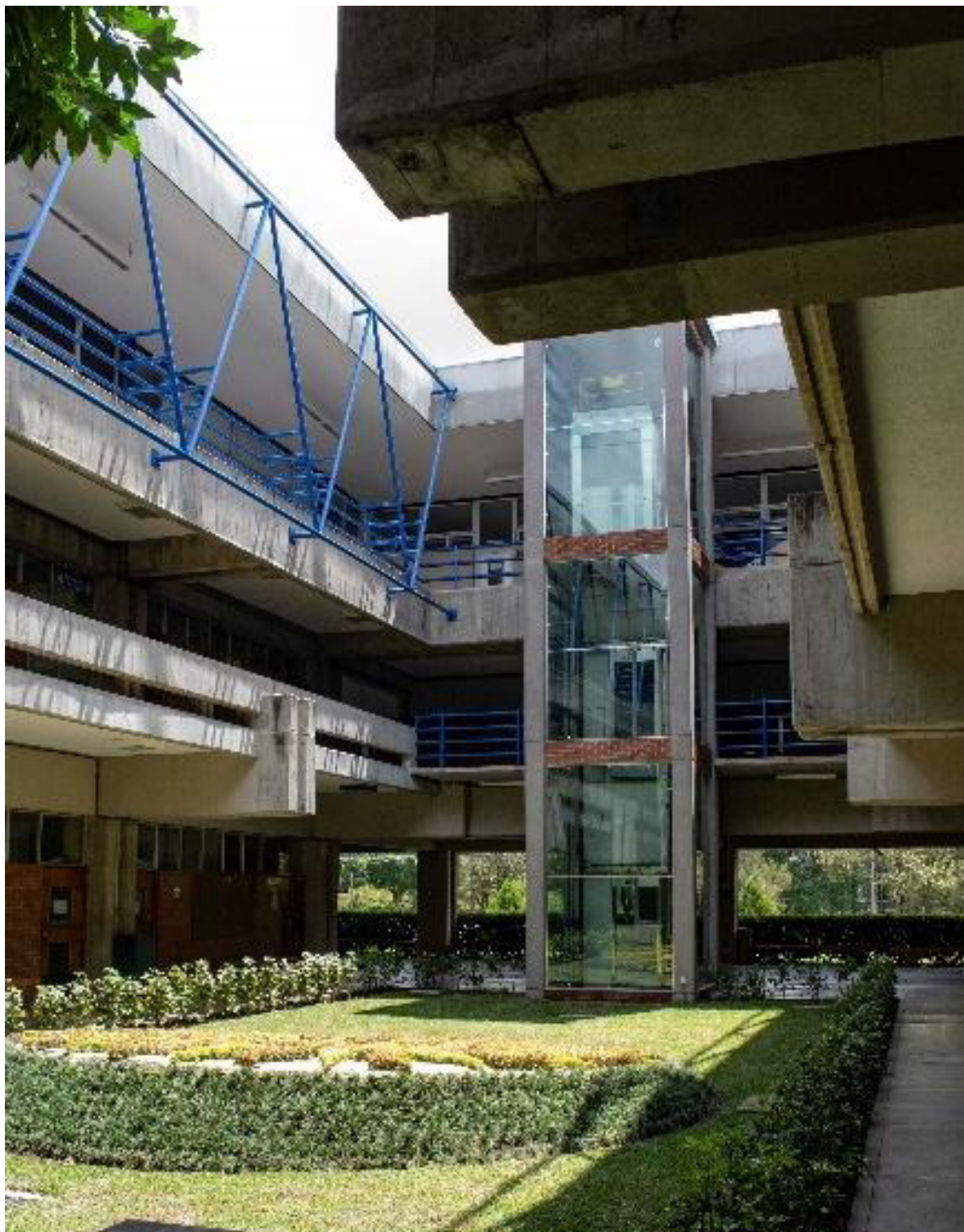
Figura 27. Vista interior del patio central en el Edificio J hacia el módulo de elevadores, en el Campus Central de la Universidad Rafael Landívar (fotografía por Pedro Ayau, © 2020 Vrip).
