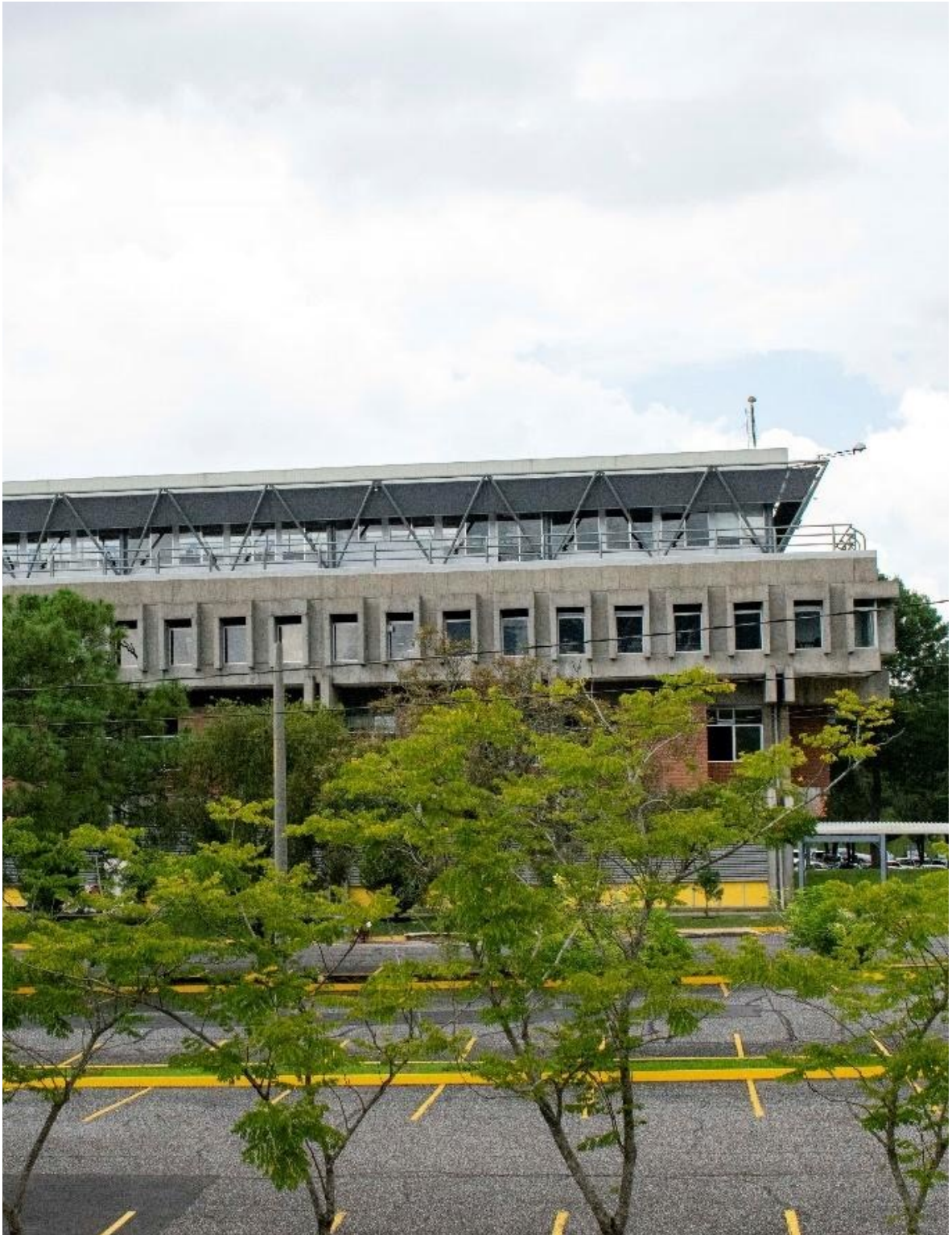
Figura 76. Vista exterior hacia el Edificio M desde el estacionamiento 4 (fotografía por Pedro Antonio Ayau, 2020).
