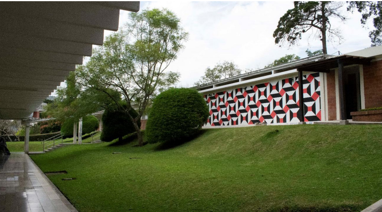
Figura 79. Vista panorámica desde Edificio TEC hacia Edificio D (fotografía por Pedro Antonio Ayau, © 2020 Vrip).
