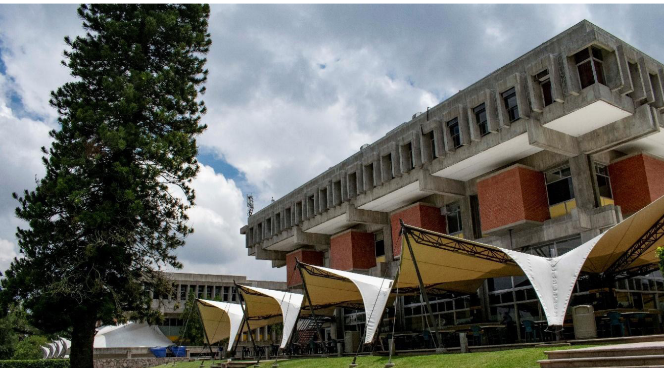
Figura 51. Vista exterior Edificio H en la Universidad Rafael Landívar (fotografía por Pedro Antonio Ayau, © 2020 Vrip).
