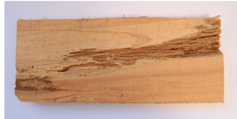
Figura 33. Daño causado por carcoma.
