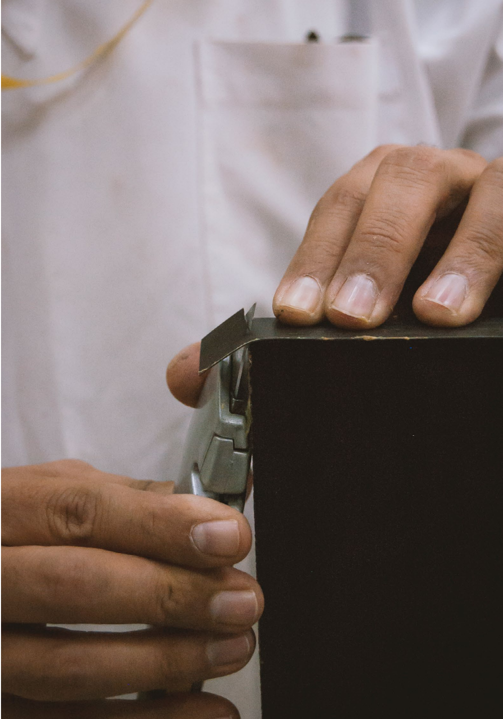
Figura 190. Recorte de exceso de tapacantos.
