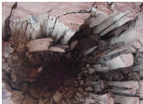
Figura 32. Daño producido por termita.
