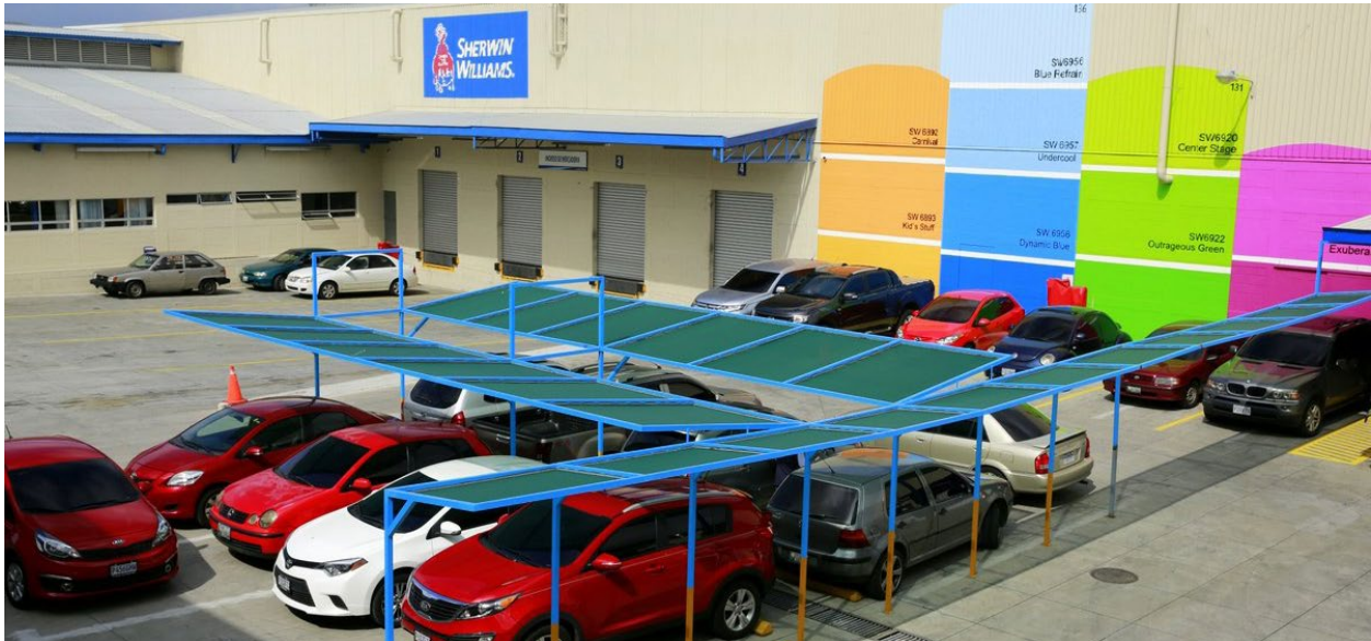
Figura 177. Edificio oficinas administrativas Sherwin Williams Guatemala certificado LEED gold -estacionamiento y área de coworking .
