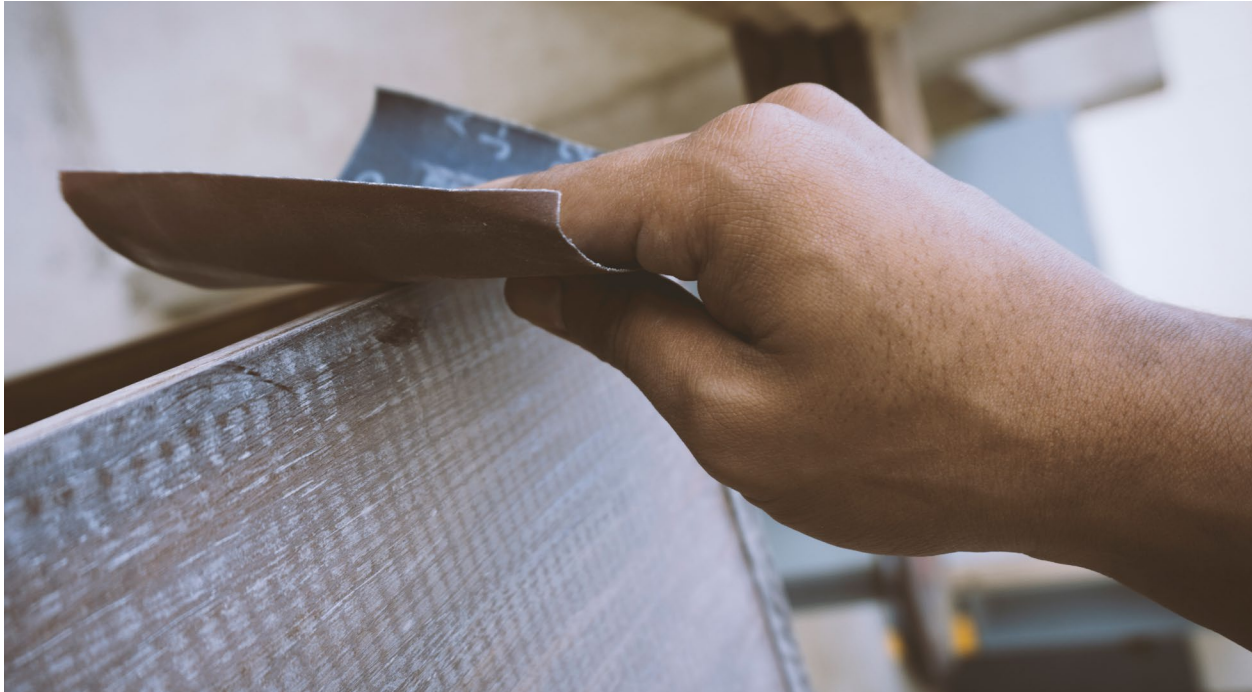
Figura 218. Proceso de lijado posterior a la aplicación de cada capa de sellador.
