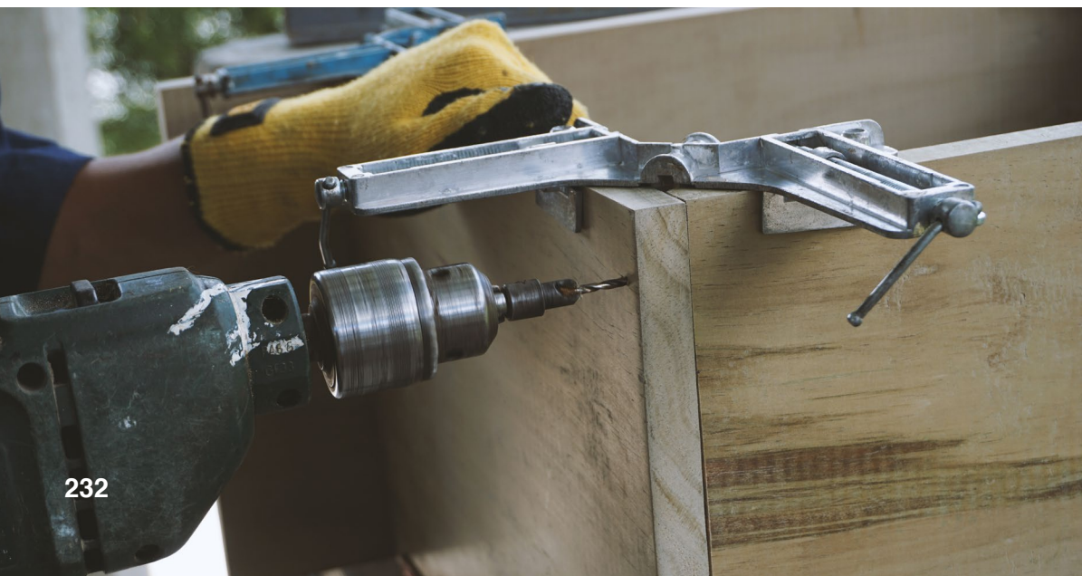
Figura 213. Perforación con broca avellanadora de 5/8".
