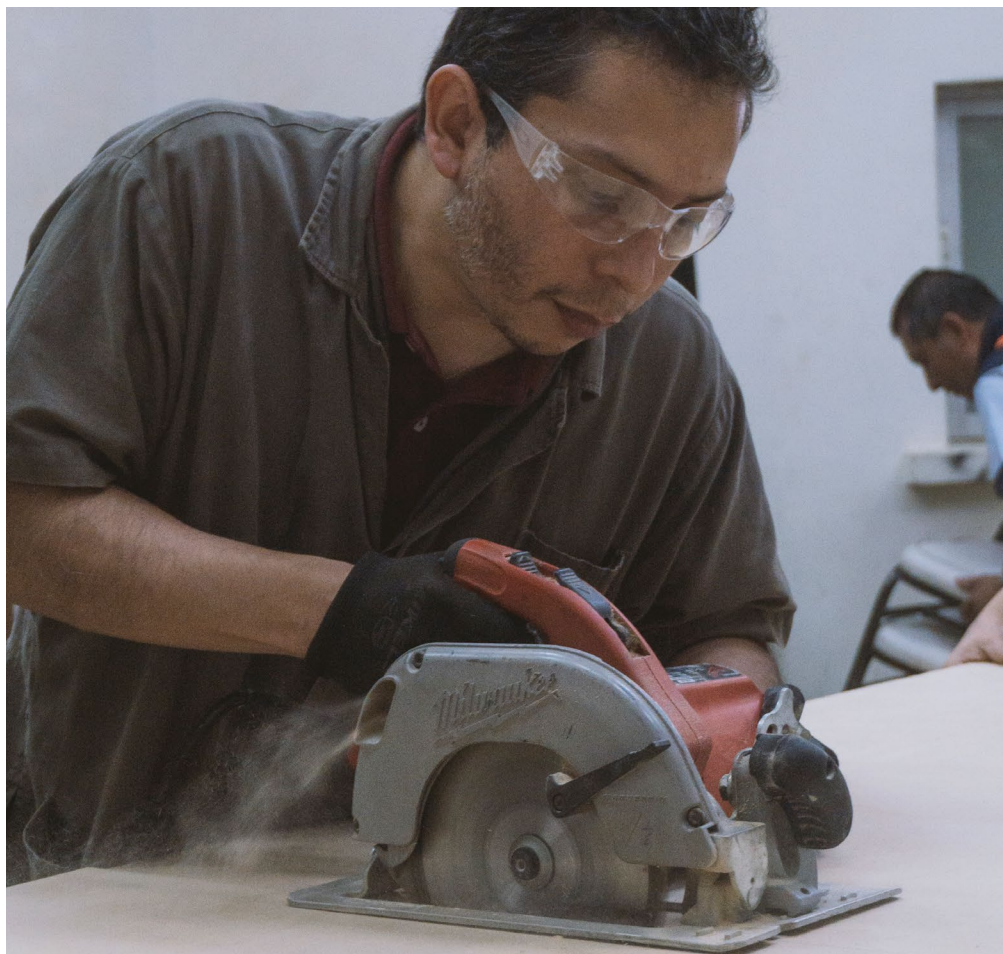
Figura 193. Reducción del tablero de MDF con sierra circular.
