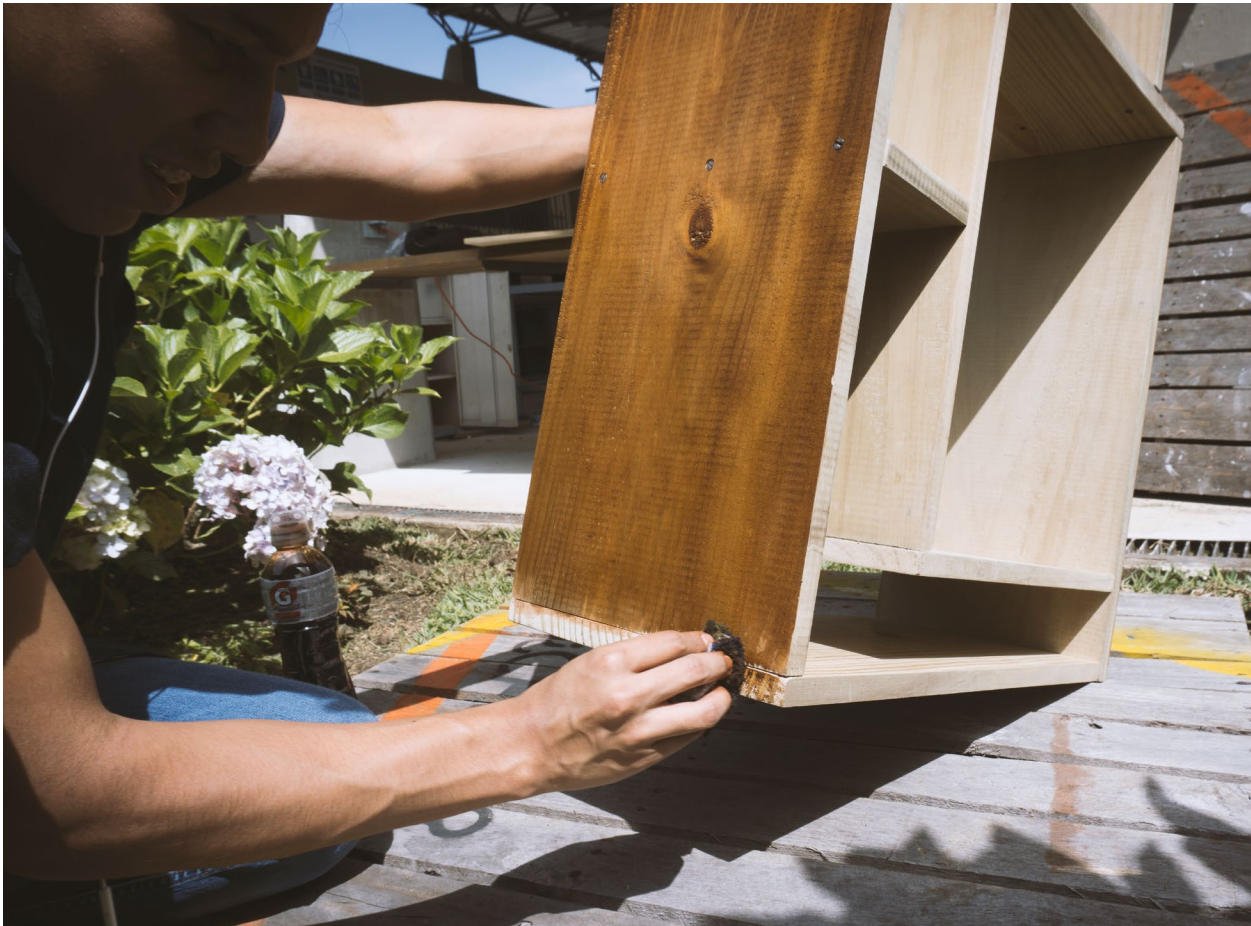
Figura 216. Aplicación de tinte nogal claro con guaipe.
