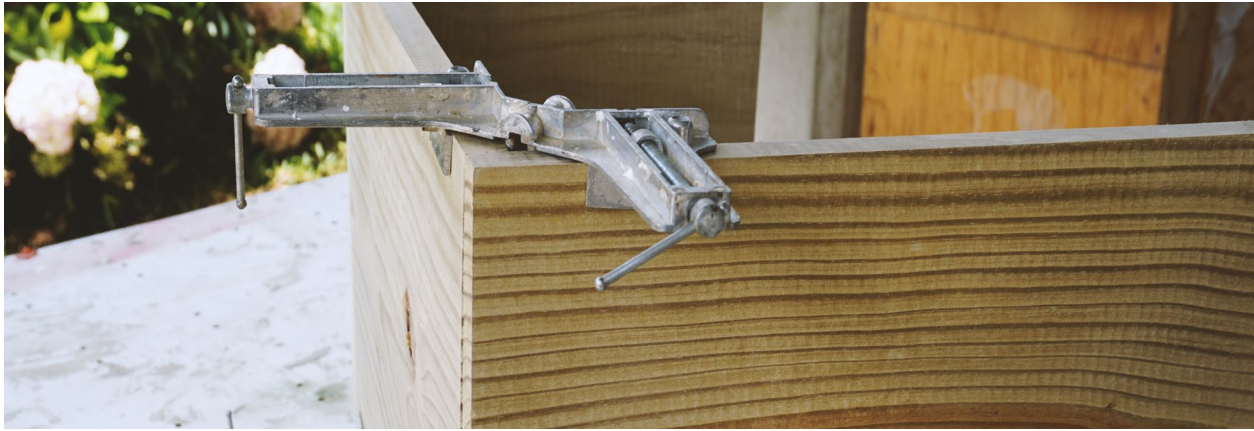
Figura 212. Colocación de escuadras para ensayo de unión.
