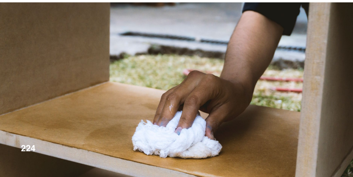
Figura 202. Aplicación de sellador con guaípe.
