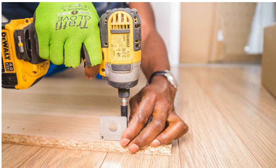
Figura 8. Los residuos en las remodelaciones suelen no tomar importancia para el desarrollo del proyecto, pero comúnmente son desechos tóxicos y que pueden afectar la salud de los ocupantes. Fuente: Bidvine en Pexels. https://bit.ly/31JijAT
