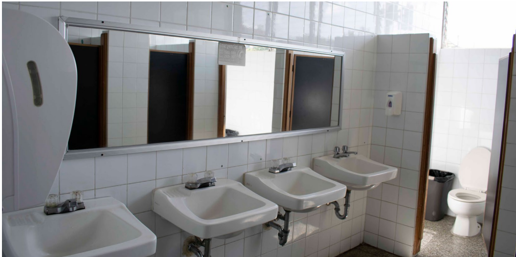
Figura 4. La loza sanitaria actual del edificio es la original, instalada desde la construcción del edificio y no cumple con los estándares de eficiencia en el consumo del agua. Fuente: Pedro Antonio Ayau, Indis.
