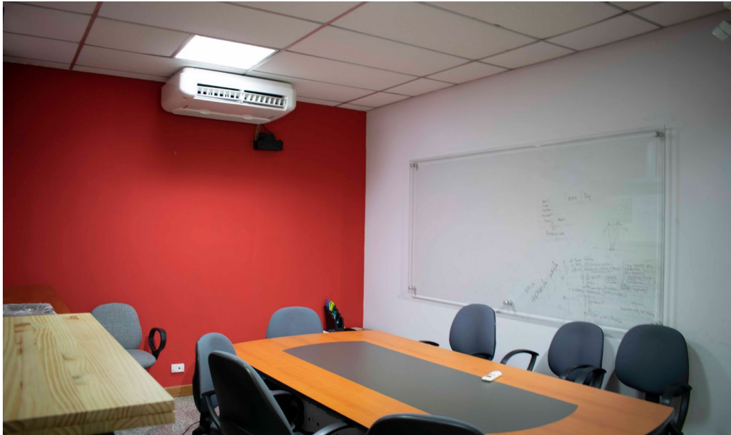
Figura 6. La fotografía expone el sistema de ventilación artificial en una de las salas de reuniones dentro del edificio. Fuente: Pedro Antonio Ayau, Indis.
