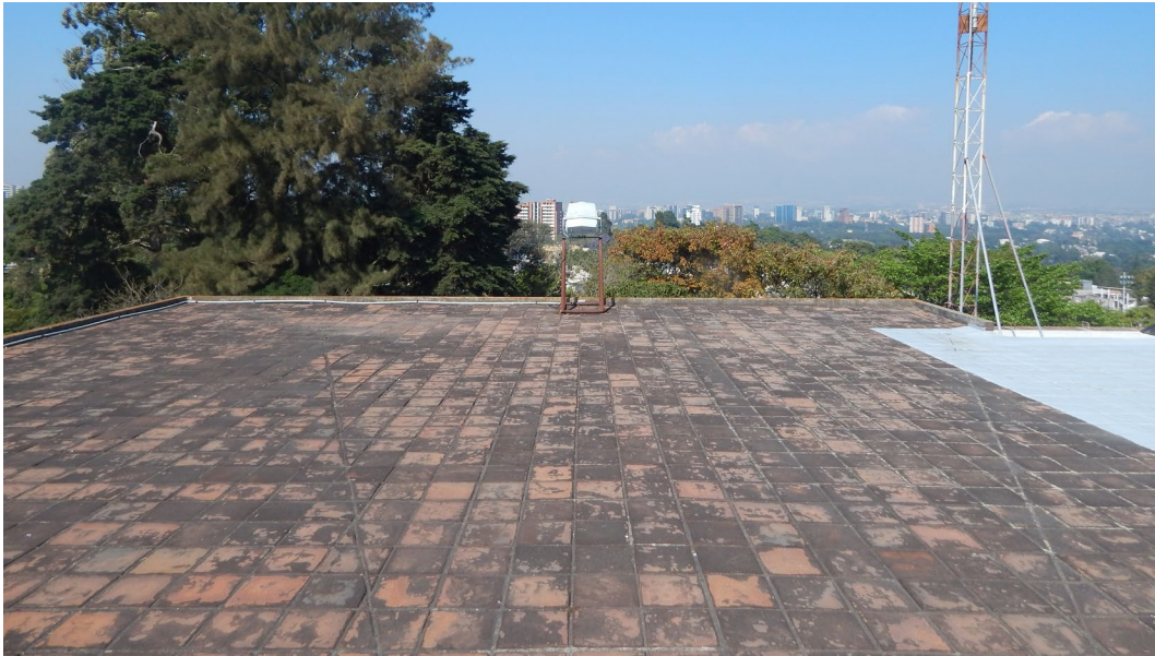
Figura 9. En la fotografía se puede observar que el acabado en la losa final es baldosa de barro, un material que aporta considerablemente a la generación del efecto Isla de Calor. Fuente: Pedro Antonio Ayau, Indis.
