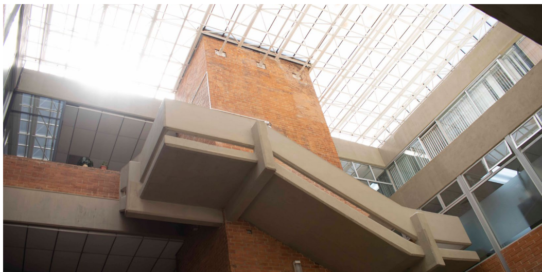
Figura 4. La ventilación principal del edificio es natural, pero algunas oficinas cuentan con sistemas artificiales que apoyan a el confort de los usuarios en el interior. Fuente: Pedro Antonio Ayau, Indis.
