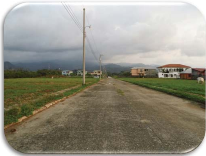
Calle de acceso a terreno Fuente: Propia ( Mayo 2014)
