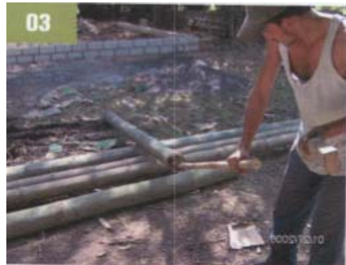
Imagen 13: cimentación del bambú.
