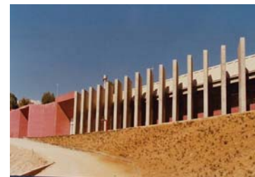
Imagen 56: parteluz en edificación.
