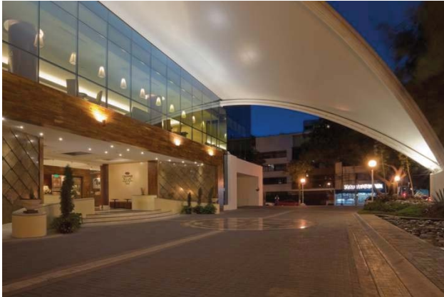
Imagen 5: plaza de acceso del hotel Crown plaza.
