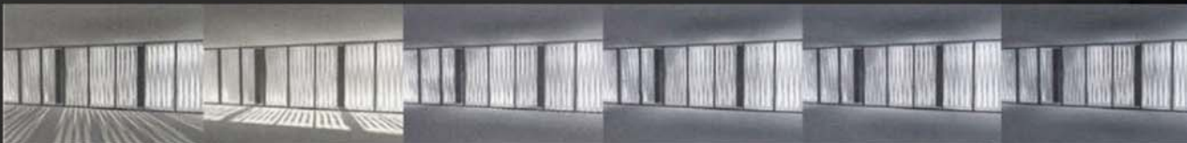
ARRIBA: EJEMPLO DEL EFECTO DE LOS PARTELUCE EN LA PROTECCIÓN SOLAR DURANTE LAS DISTINTAS HORAS DEL DÍA. MODERN CONSTRUCTION ENVELOPES 2011
