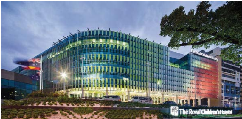
Izquierda: Fachada del Hospital
