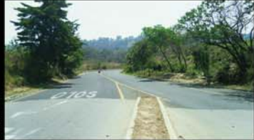
INTERSECCIÓN ENTRE LA ROTONDA Y EL CAMINO PARTICULAR.
