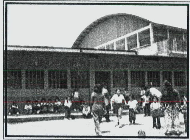
Fotografía No. 14: Interior de la Escuela Anexa para Párvulos. Fuente: Elaboración Propia Año:2,005
