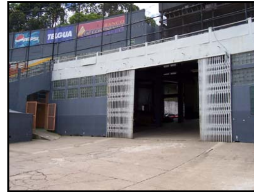
Foto No.43 Salida hacia cancha y pista
