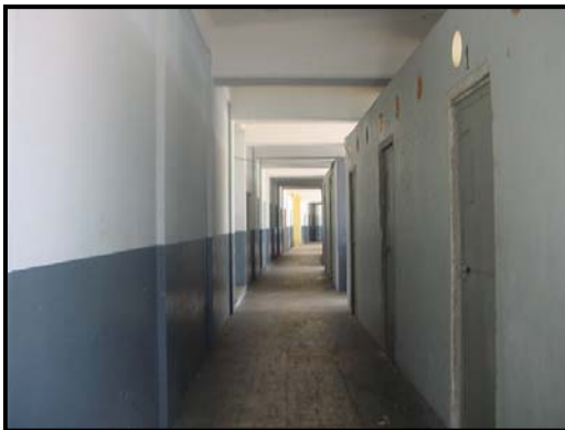
Foto No.26 Acceso a las cabinas de transmisión
