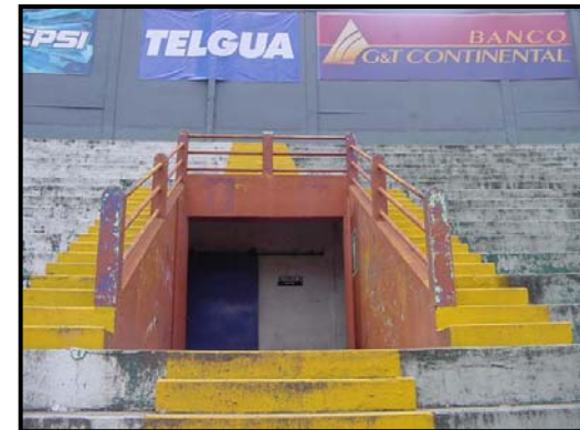
Foto No.32 Servicio sanitario General Sur
