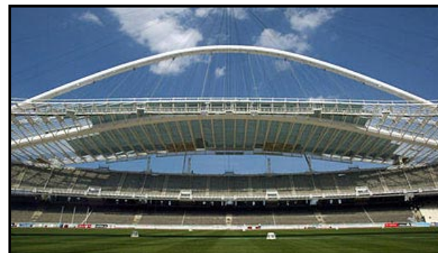
Foto No.12 Tribuna y cubierta Estadio Olímpico de Atenas
