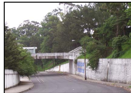
Foto No.55 Área verde junto a la 11 avenida, y pasarela
