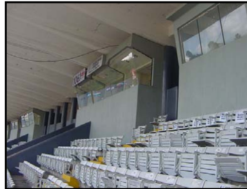
Foto No.27 Cabinas de transmisión
