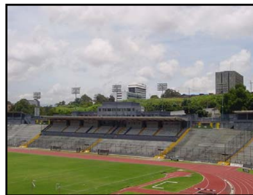
Foto No.51 Torres de iluminación del sector de palco
