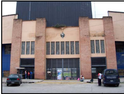
Foto No.42 Fachada acceso de atletas
