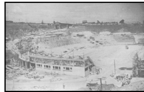
Foto No.14 Vista del estadio durante su construcción
