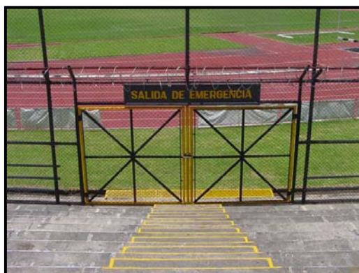
Foto No.40 Salida de emergencia hacia campo
