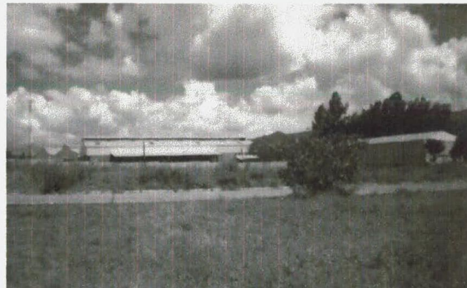
Fotografía, Bodega de Industria de productos plásticos / fuente: elaboración propia
