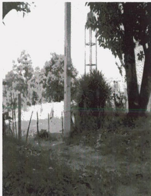
Fotografía, Acometida Eléctrica / fuente: elaboración propia
