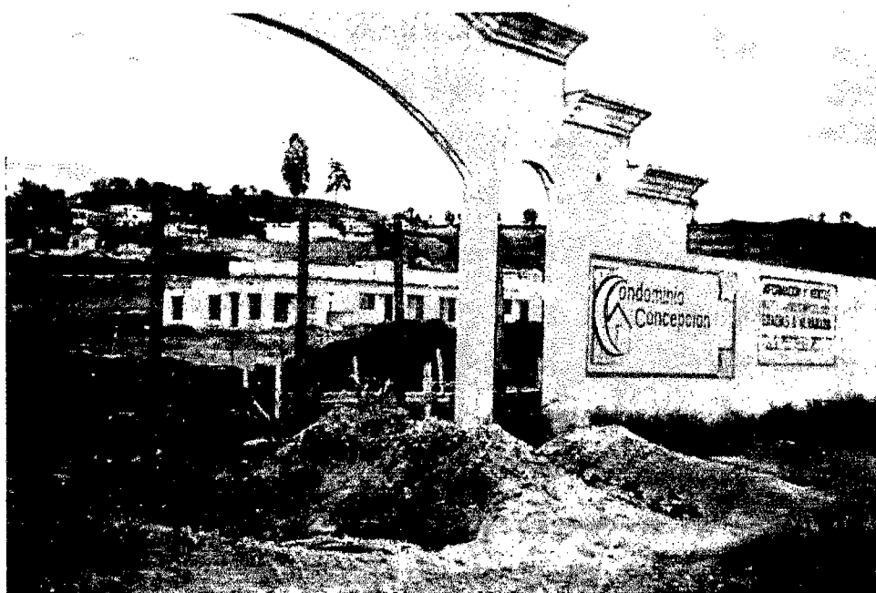
FOTO No. 3.4 Condominio Concepción. El movimiento de tierras crea problemas ocasionando mayores inundaciones en la parte baja del cantón.
