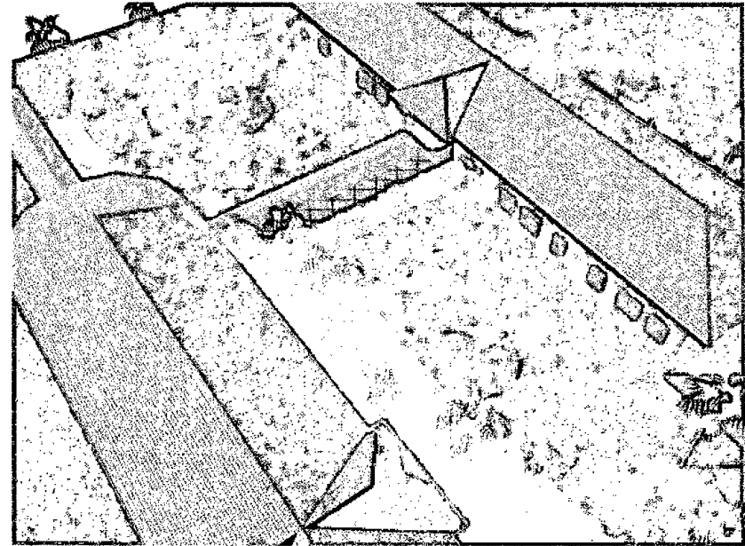
Vista aérea de edificios de aulas tipo 2.
