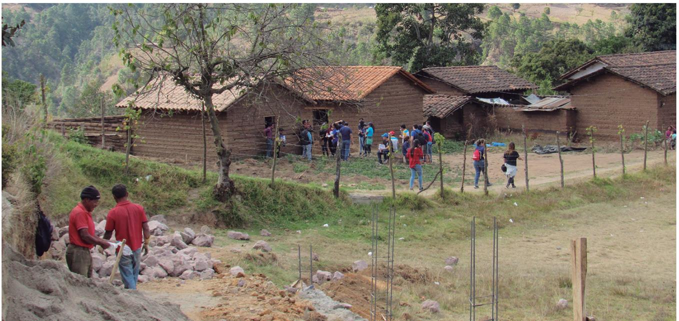
Fotografía 1. Evidencia de la combinación de técnicas constructivas tradicionales y contemporáneas. En primer plano, construcción de columnas de concreto reforzado y de fondo, vivienda vernácula de construcción en tierra.
