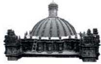
1,868 tejas coloniales ubicadas bajo el ladrillo pastelero, las cuales, en su mayoría, se encontraban en pésimo estado de conservación (rotas y fracturadas en varios lugares); luego, se procedió a retirar el mortero antiguo, ubicado entre las juntas de 4,150 ladrillos pasteleros aplantillados de cada bóveda, para sustituirlo con otro mortero nuevo con similares características.
