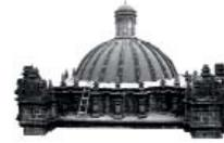
drillos pasteleros de las cubiertas en mal estado, la refacción de los canales de evacuación de las aguas pluviales de todas las bóvedas, la rectificación de las pendientes de los canales de aguas pluviales, así como la rectificación y mejoramiento de las cajas de piedra inferiores, que es donde se recibe el agua que cae de las gárgolas.
