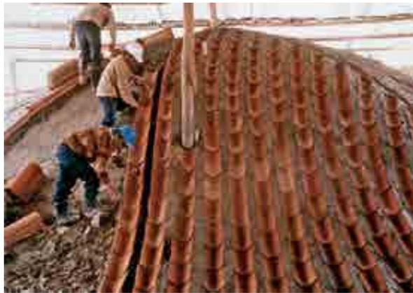
Liberación de ladrillo pastelero y mortero en mal estado. Colocación de nuevas tejas.
