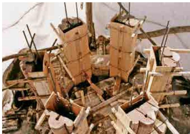
Tallado de la piedra para las columnas y arriostre de las columnas talladas.
